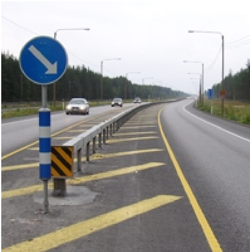
Kuva 15 Kokoon painuva kaiteen pää (Kuva Maanmittauslaitoksen WWW-sivut)
