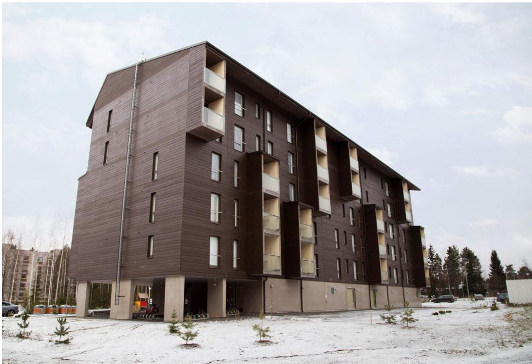
Kuva 14. Lintuviita 2, Seinäjoki. (Stora Enso. 2013. Projektit: Lintuviita.)
