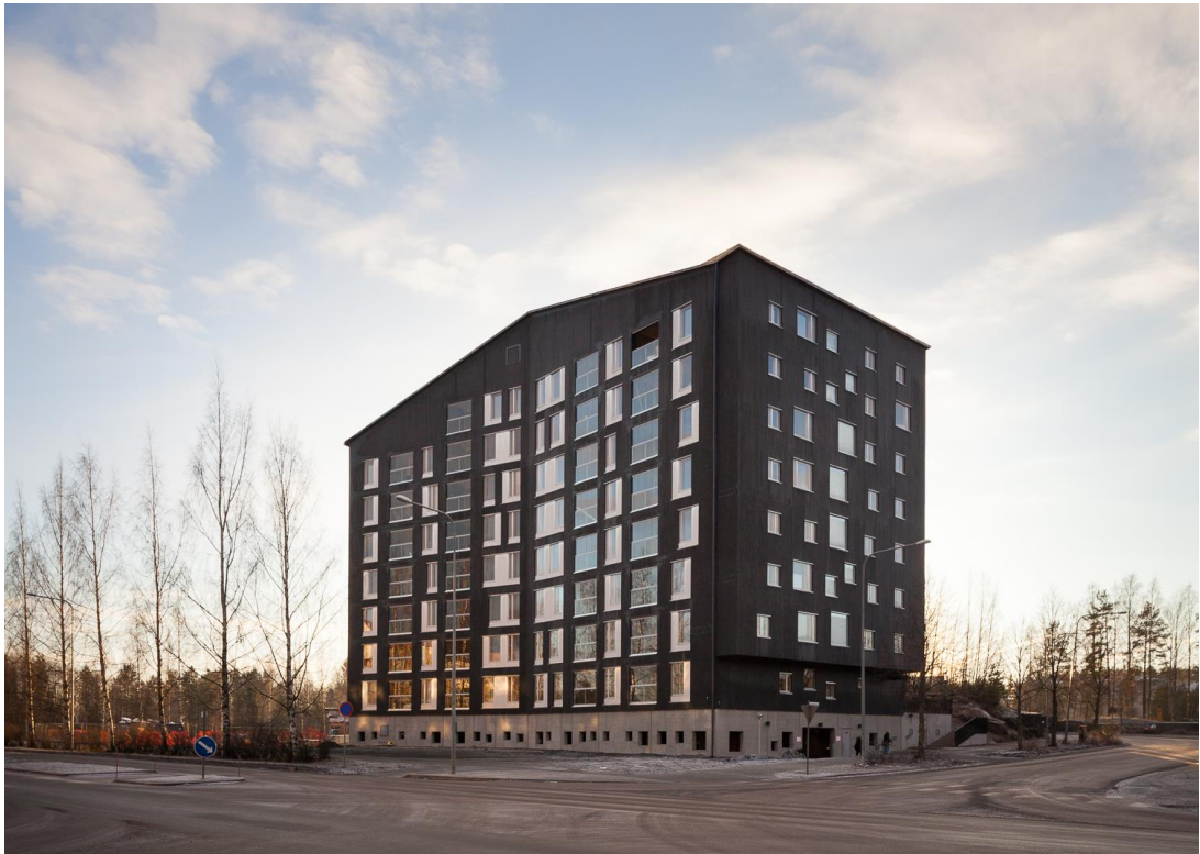
Kuva 15. Puukuokka, Jyväskylä. (Stora Enso. 2013. Projektit: Puukuokka.)
