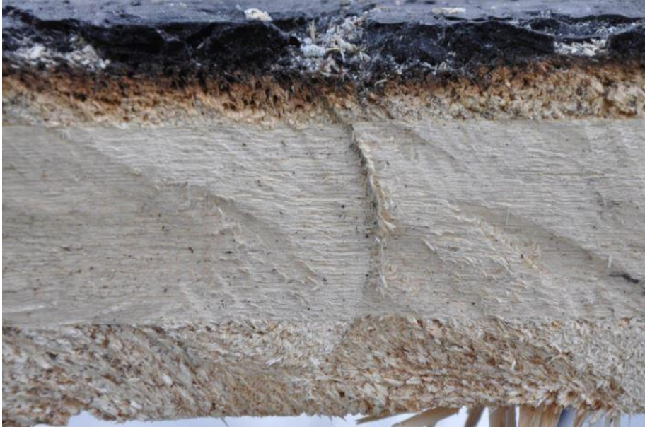
Kuva 3. CLT-levy polttokokeen jälkeen. (Stora Enso. 1/2014. CLT Fire Protection.)
