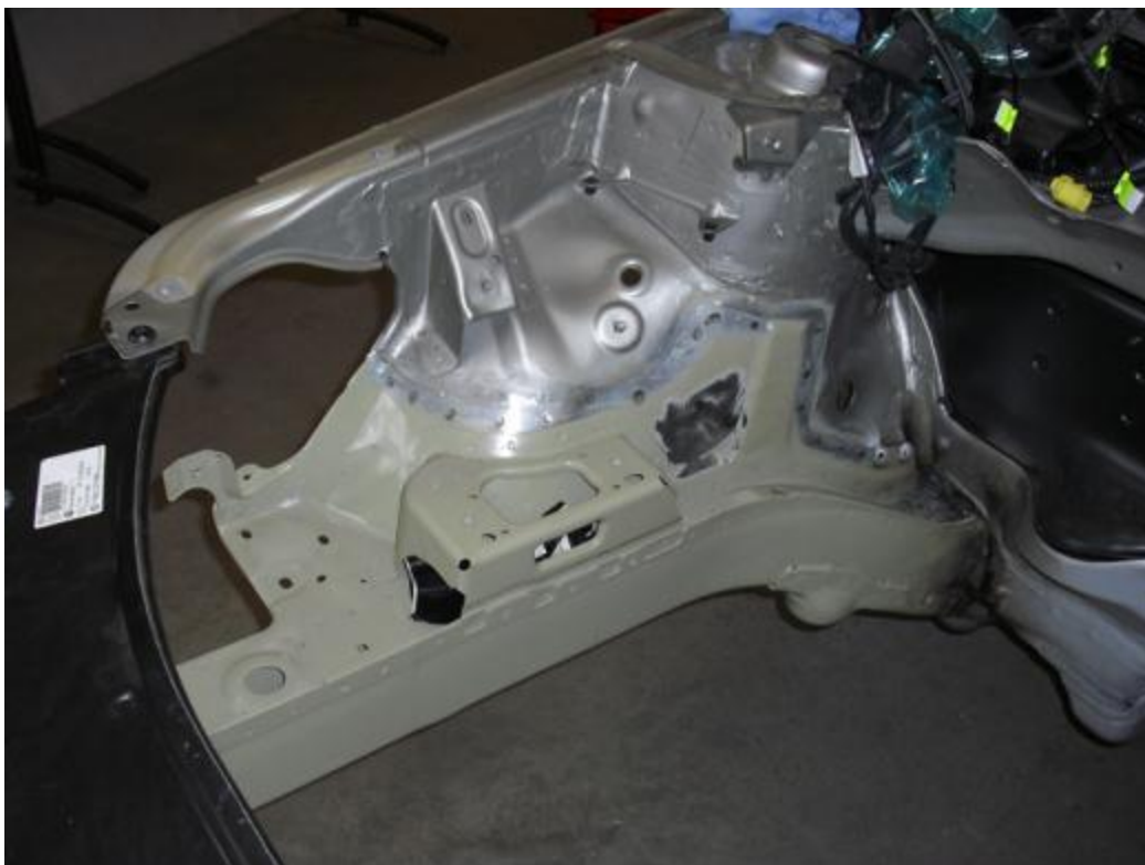
Kuva 23. Oikea runkoaisa vaihdettuna ennen maalaustyötä
