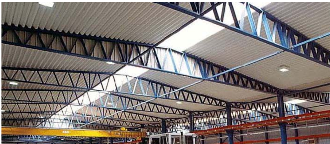
Kuvio 3: Kantavat poimulevyt asennettu primäärikannattajien päälle. (Ruukki Oyj 2009, 2.)
