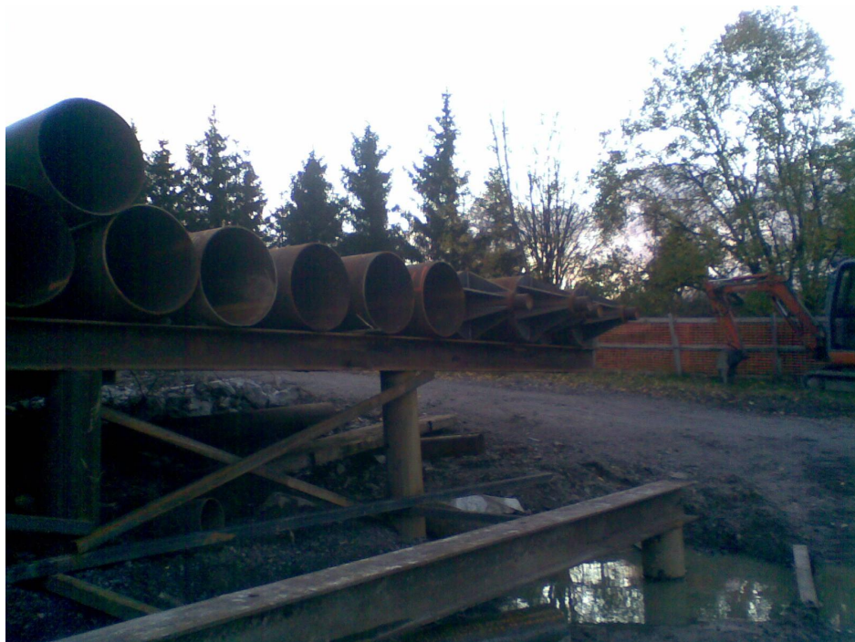
Kuva 12. Kalliokärjillä varustettuja paaluja
