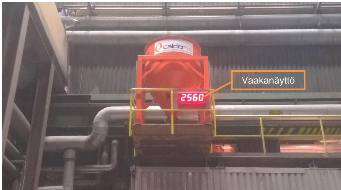
Kuva 15. Siilo lattiatasolta katsottuna
