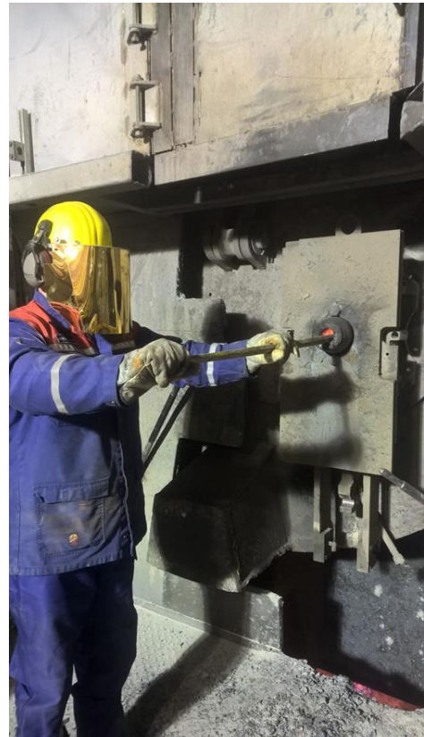
Kuva 33. Putki poistetaan kangen avulla
