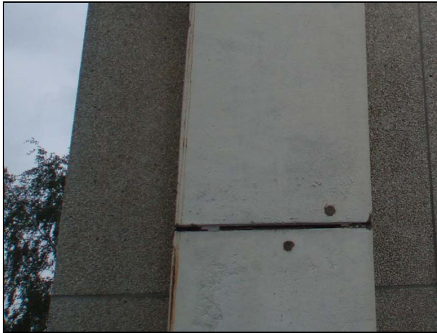
Kuva 5 Ruostevalumaa piipun vasemmalla puolella
