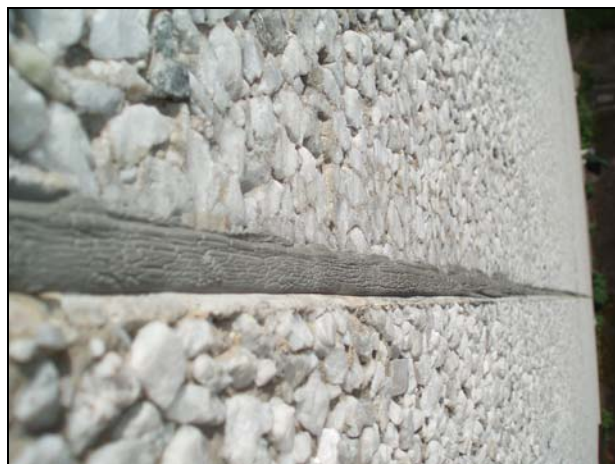
Kuva 4 Puristunut elementin sauma
