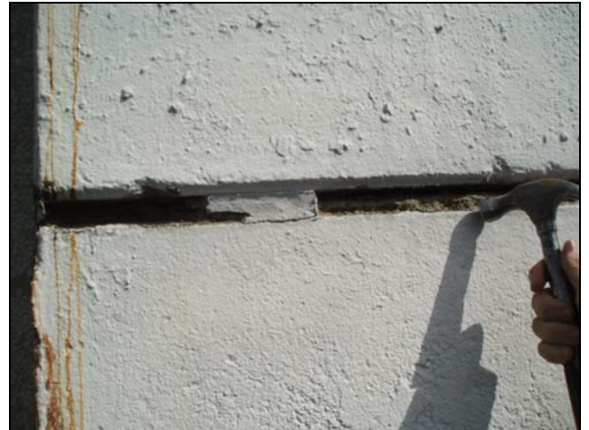
Kuva 6 Piipun elementtien sauma
