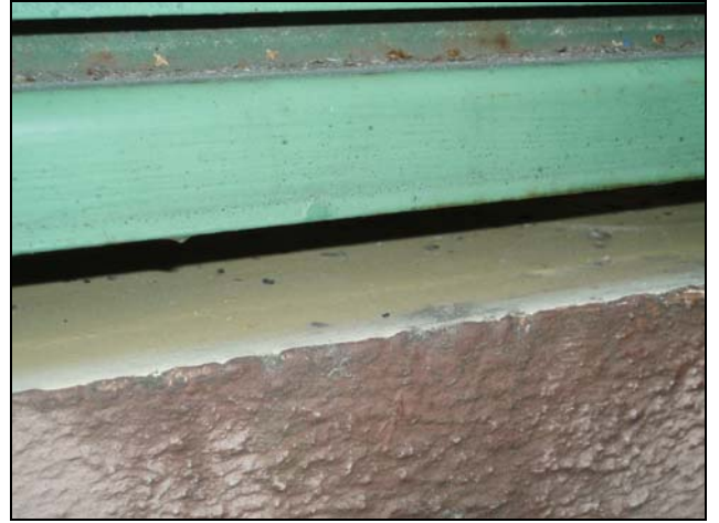
Kuva 11 Parvekelaatan etureunan pinnoite
