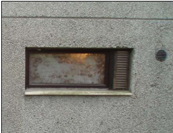
Kuva 7 Pohjoissivun alkuperäinen ikkuna
