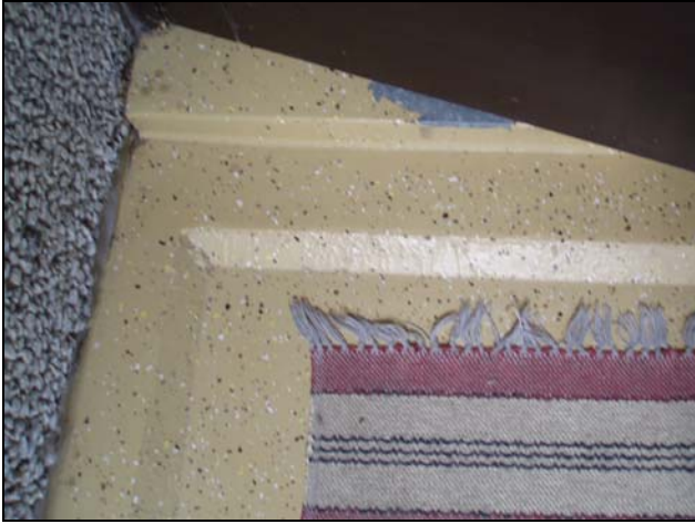
Kuva 10 Parvekelaattojen pinnoite
