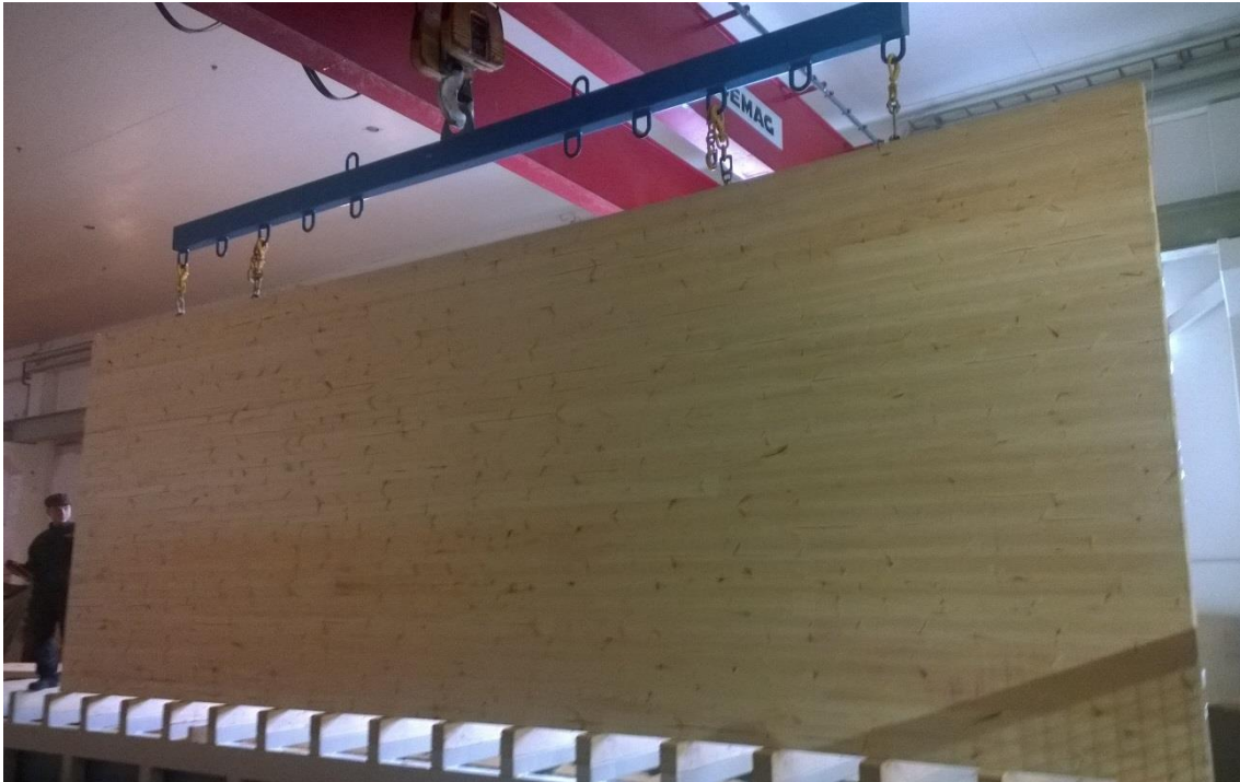
KUVA 8. CLT-levy nostettu pystyasentoon ruuveja ja nostoapuvälineitä käyttäen
