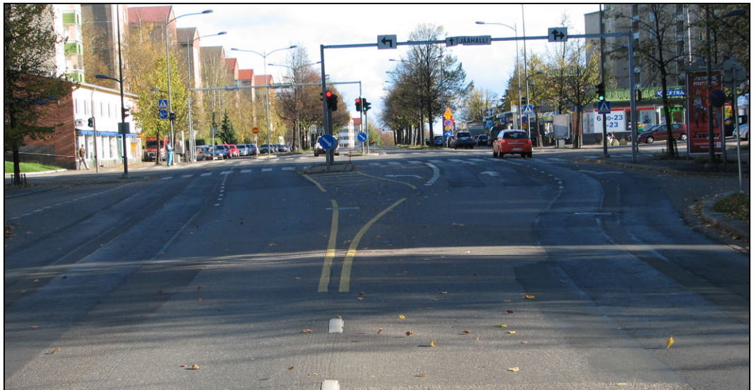
Kuva 10 Liittymäalueen ryhmityskaistojen välisiä ajokaistaviivoja ei ole päätetty eikä jatkettu.
