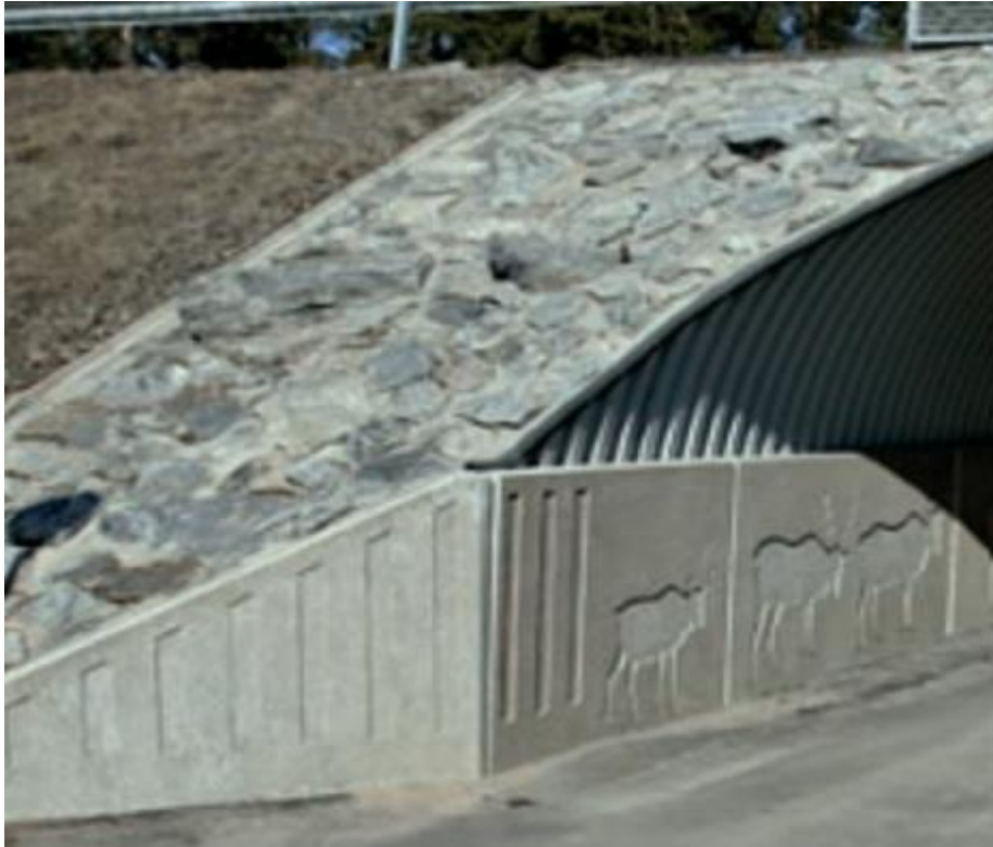
Kuva 18. Anturan pintakuvionti (Rumtec Oy)
