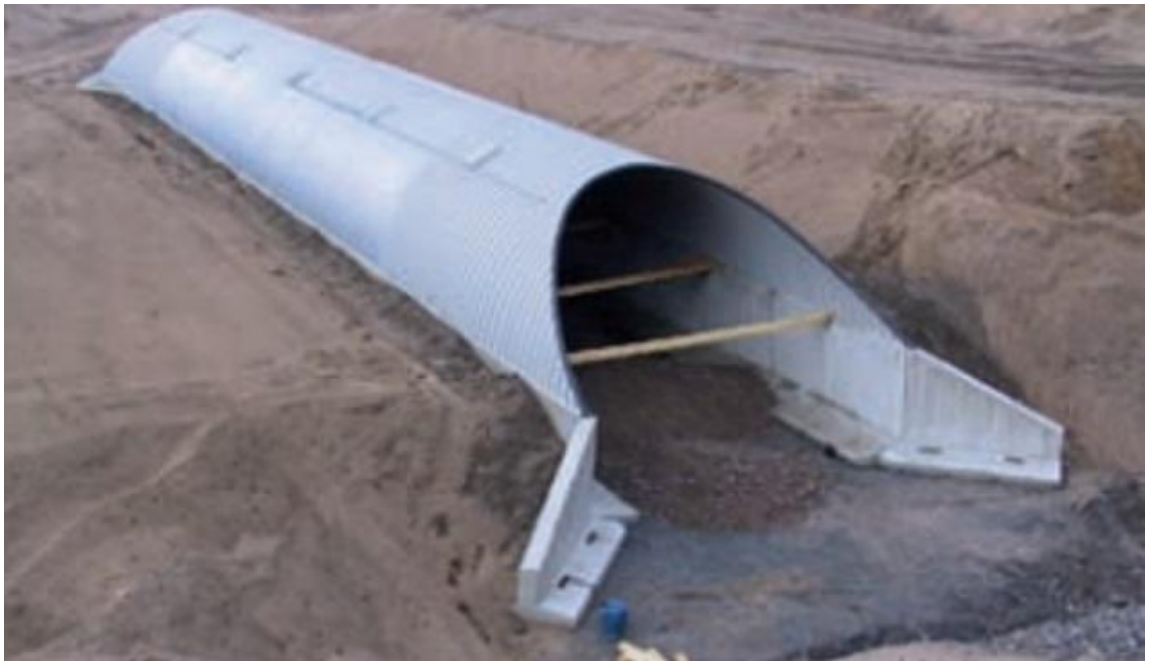
Kuva 4. holvisilta (Viacon Oy)
