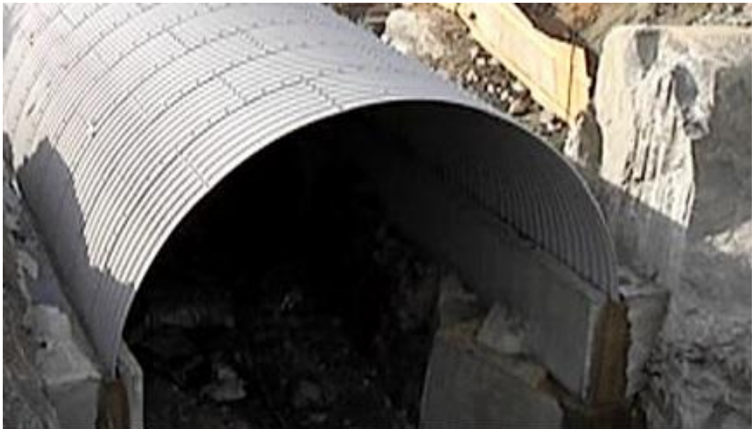
Kuva 3. monilevy rakenne (yle.fi)
