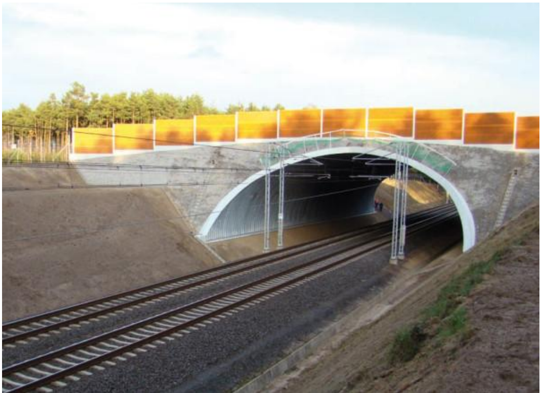
Kuva 5. Supercor-silta (Viacon Oy)
