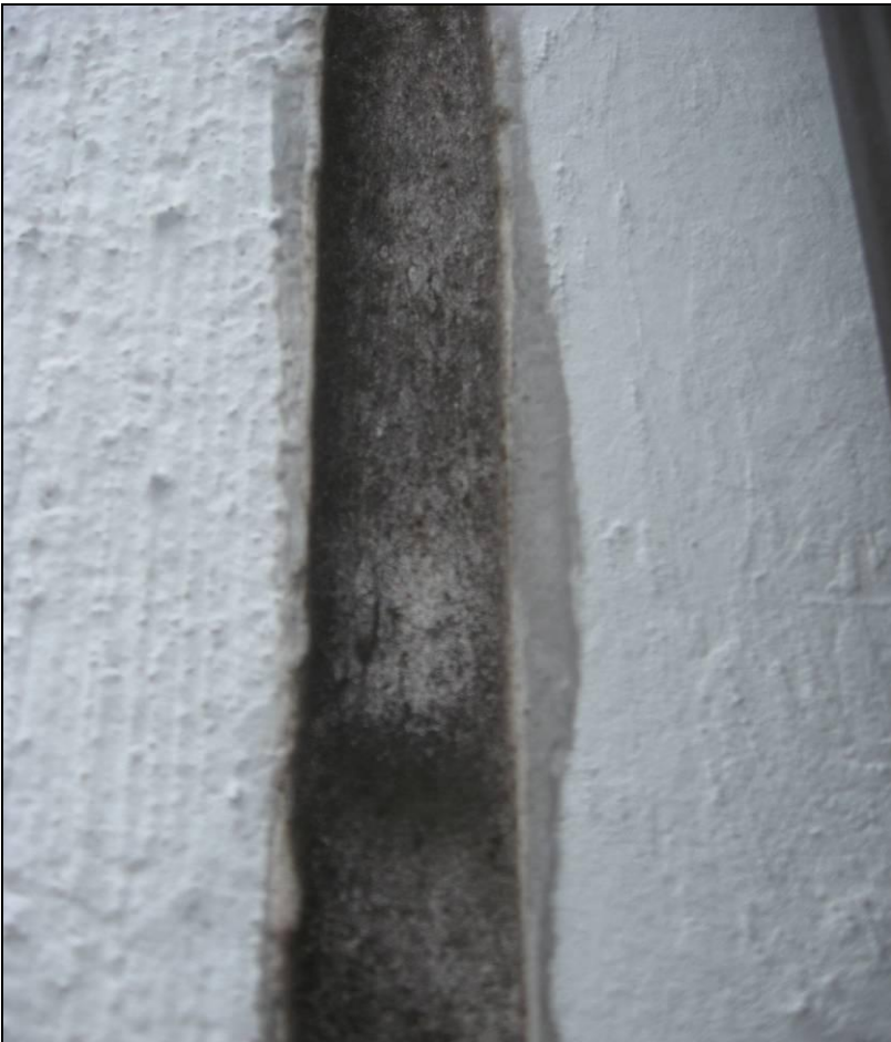
Kuva 3 Lyijyä sisältävä saumamassa
