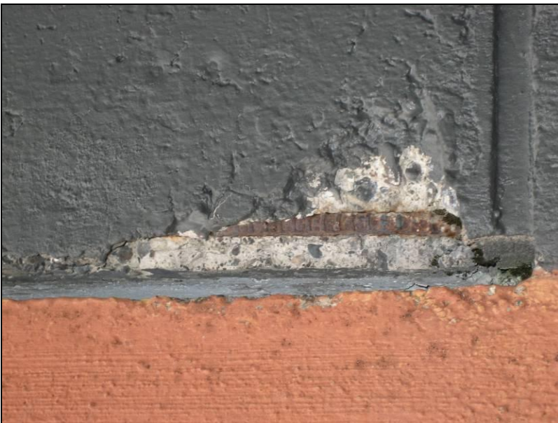
Kuva 4 Teräskorroosioaurio
