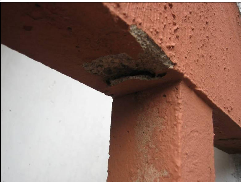
Kuva 6 Teräskorroosioaurio parvekekaiteessa
