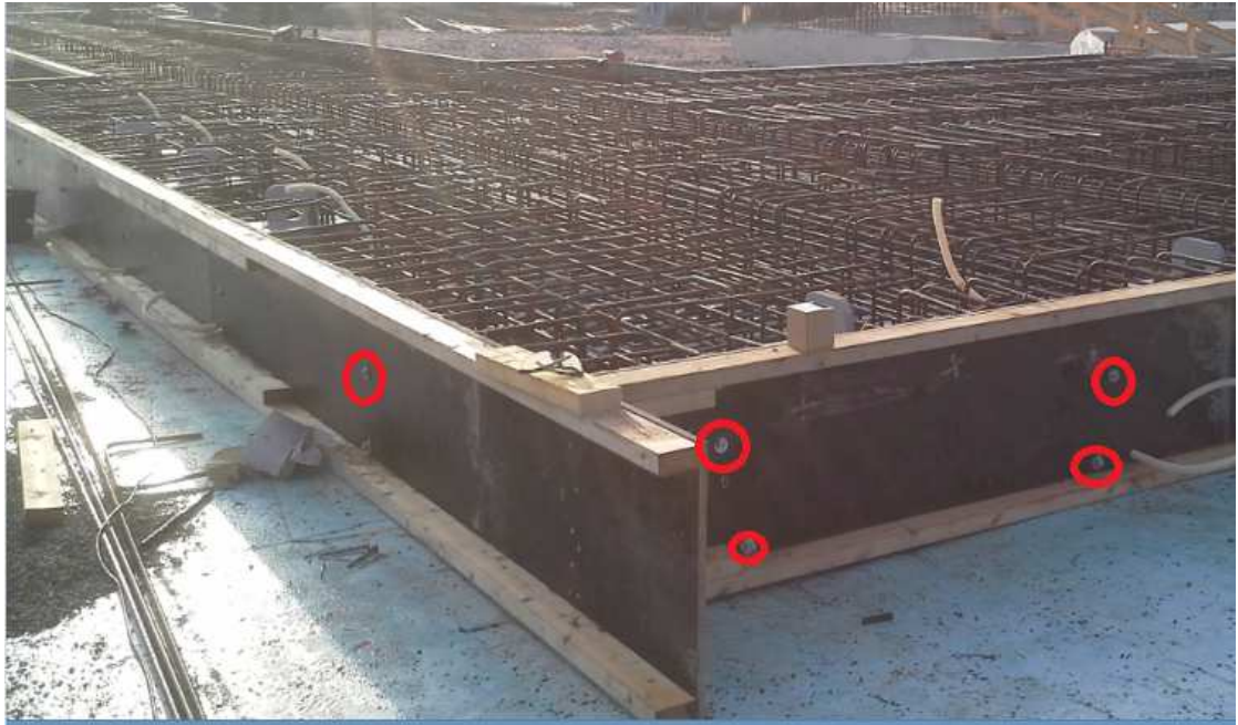
Kuvio 13 Muottien kiinnitys pulteilla teräksiin
