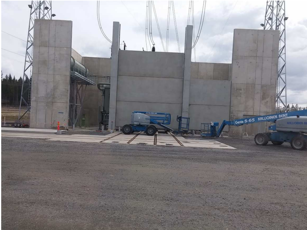
Kuvio 19 Suojaseinäelementtien asennus
