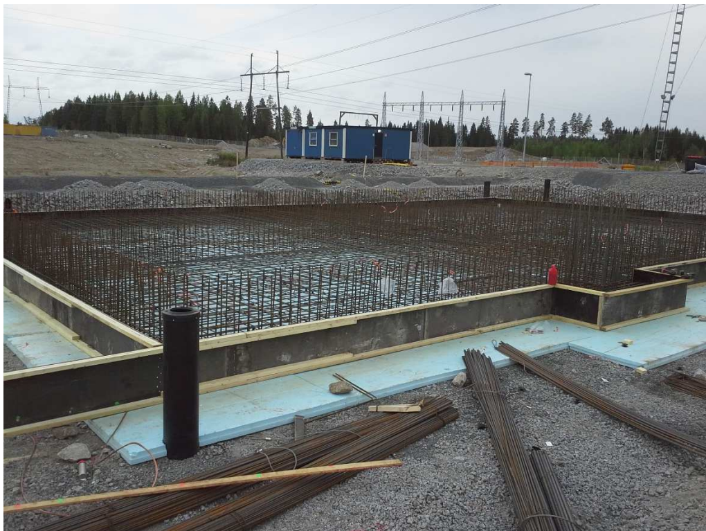
Kuvio 3 Pohjalaatan raudoitus valmis ja muotit asennettu
