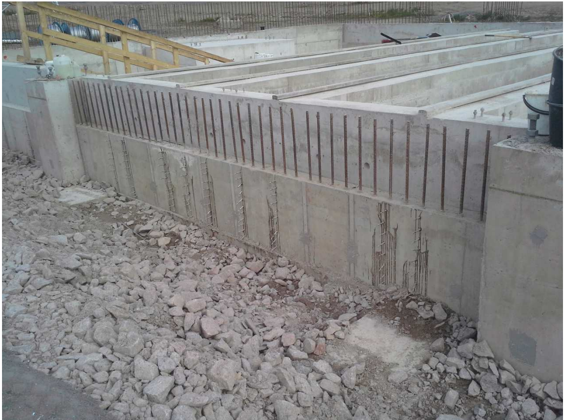
Kuvio 11 Halkeamien injektointi
