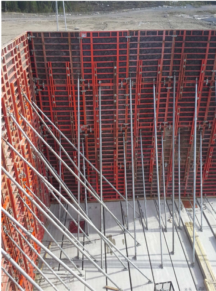
Kuvio 15 Sisäpuolen muotit asennettuna
