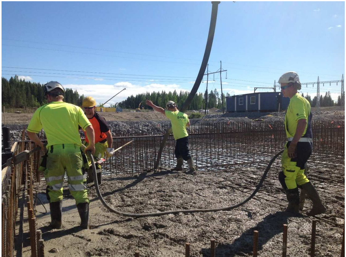
Kuvio 4 Pohjalaatan valu käynnissä
