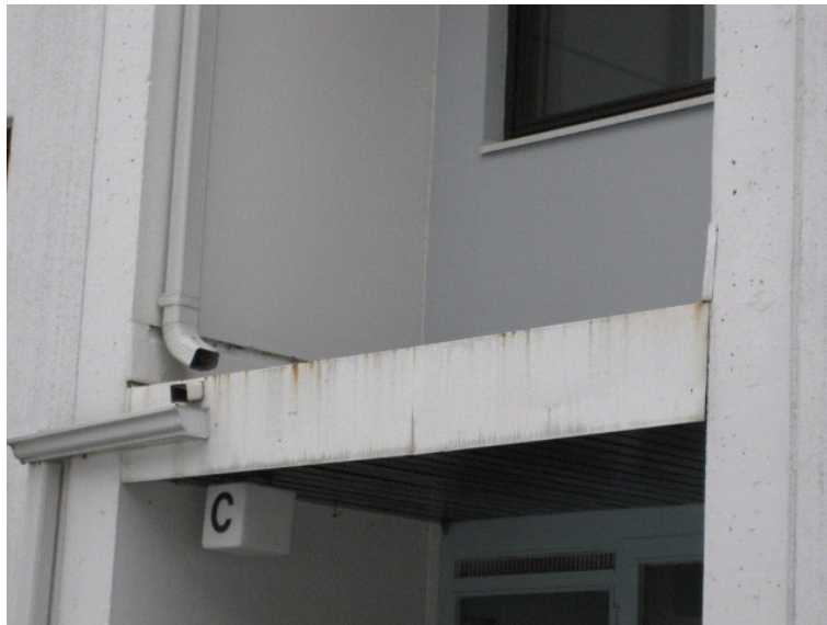
Kuva 15 Tuuletusparvekkeen vedenpoisto
