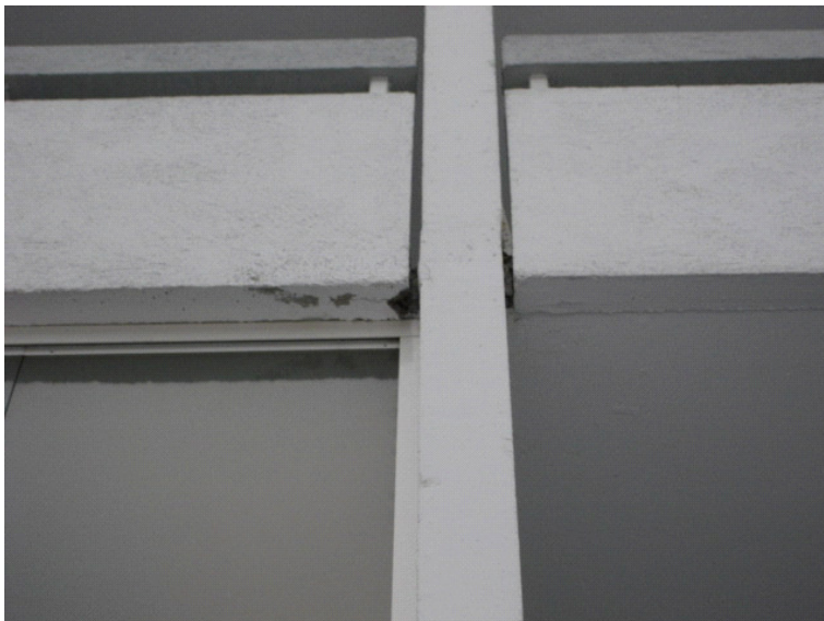
Kuva 6 Lohjennut betonikaide
