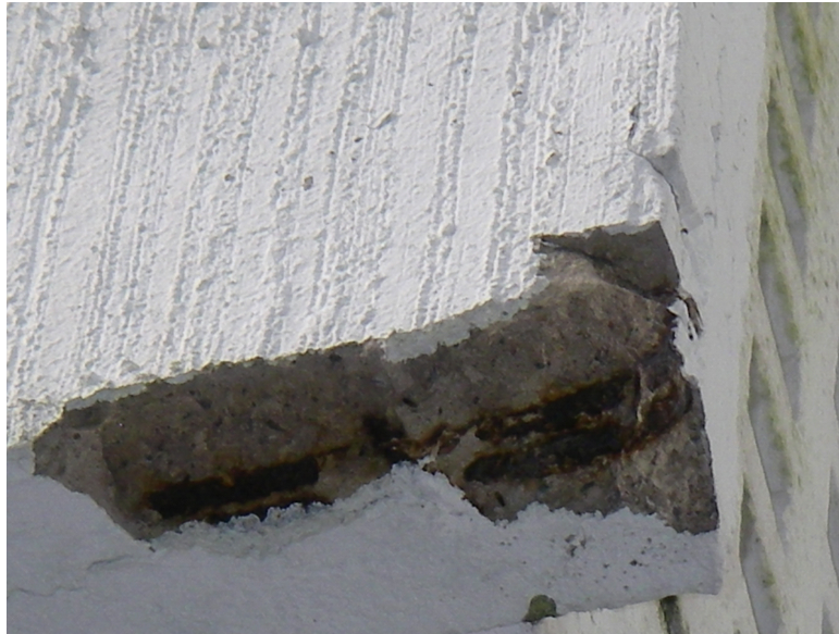
Kuva 4 Parvekekaiteen korroosioaurio /3/
