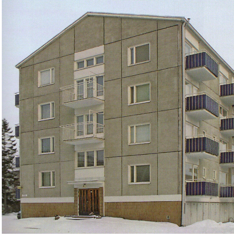
Kuva 8 Ensimmäinen betonisandwich-elementeistä tehty asuinkerrostalo /7, s. 85/
