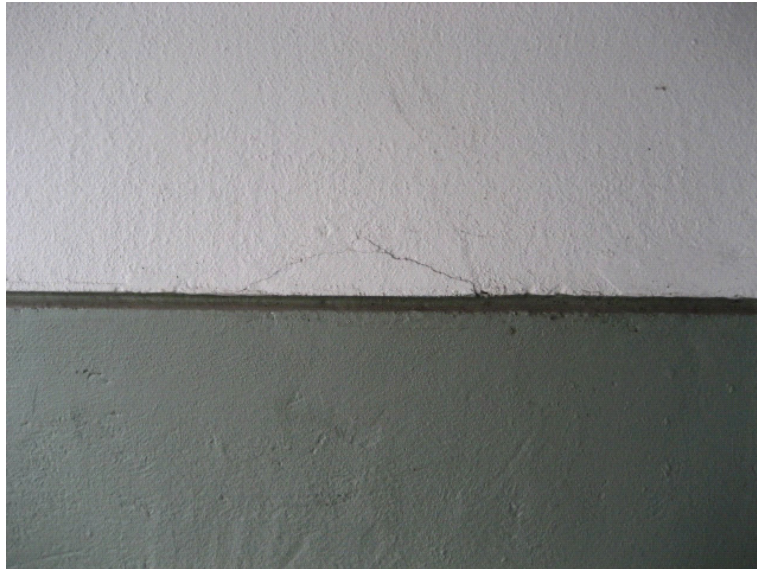
Kuva 3 Halkeama sandwich-elementissä
