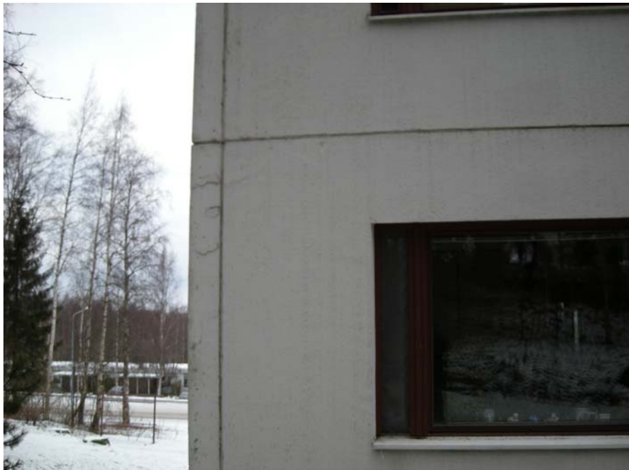
Kuva 5 Päätyelementin halkeilua.
