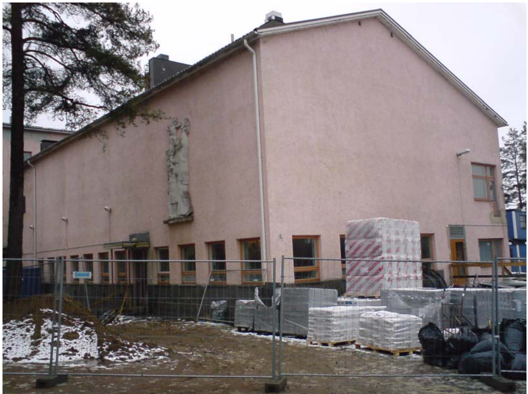
Kuva 3 D-osan länsipääty ja varastointialuetta
