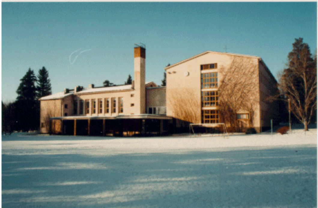
Kuva 2 Koskenmäen koulu etelästä päin kuvattuna, oikealla C-osan pääty ja vasemmalla D-osan eteläjulkisivu /7/
