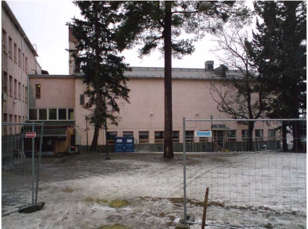
Kuva 4 D- ja C-osan risteys pohjoisen työmaa-ajoportilta kuvattuna
