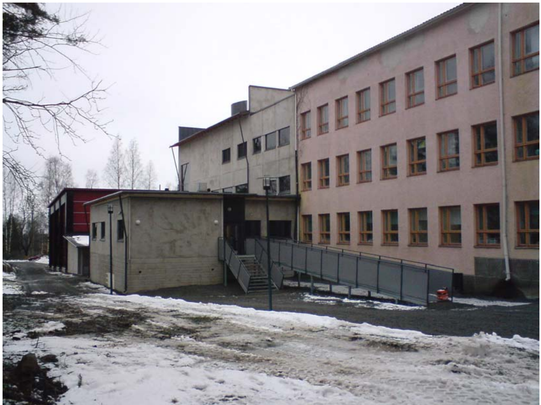
Kuva 6 C-osan itäisivun julkisivua ja laajennusosan liitoskohta
