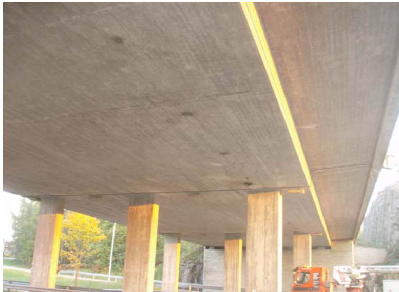
Kuva 26 Sillan kolme eteläisintä aukkoa
