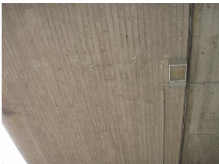
Kuva 18 Valokuva sillan eteläreunasta
