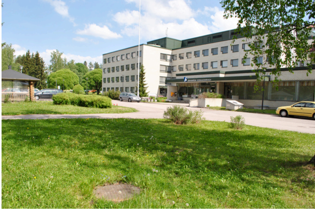
Kuva 3. Pääsisäänkäynnin piha-alueita. Liikenne kulkee vapaasti ovien ja tupakkapaikan (vasemmalla) välistä. Kuvassa näkyy 1970-luvulla valmistunut äskettäin remontoitu laajennus. Cecilia Holst, 2014.
