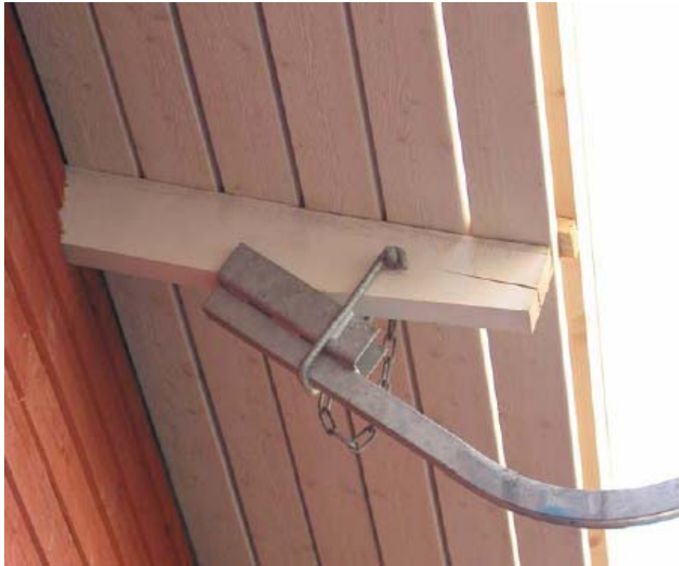
Kuva 8 Haljennut kattovasan pää /4/
