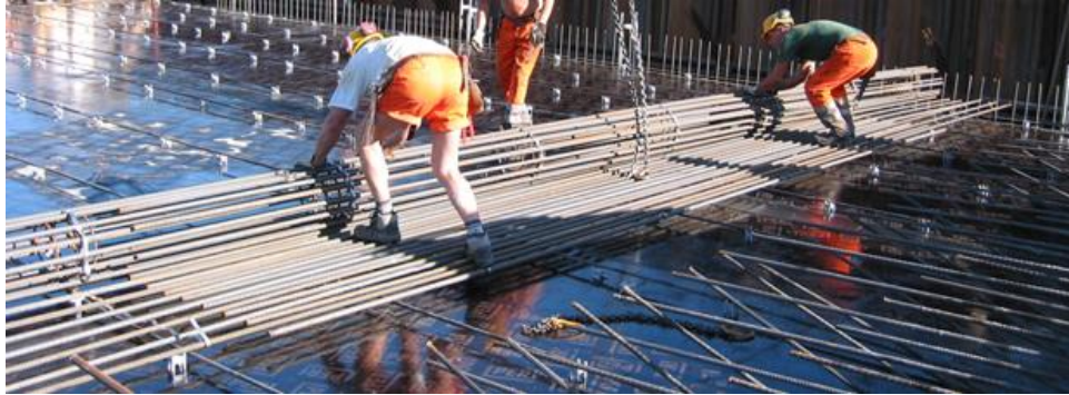
Kuva 14. Raudoitustyö rullaraidoiteella (Bamtec n.d.).
