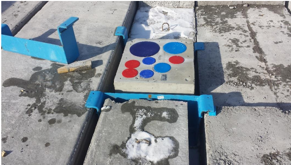
Kuva 4. Ontelolaatan kannakepalkit (Kuva: Toni Aalto).
