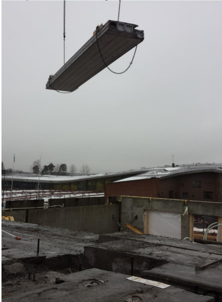
Kuva 9. Ontelolaatan asennus (kuva: Toni Aalto).
