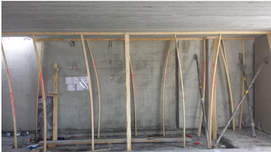
Kuva 10. Ontelolaattavälipohjan saumojen tuketyöt (kuva: Toni Aalto).
