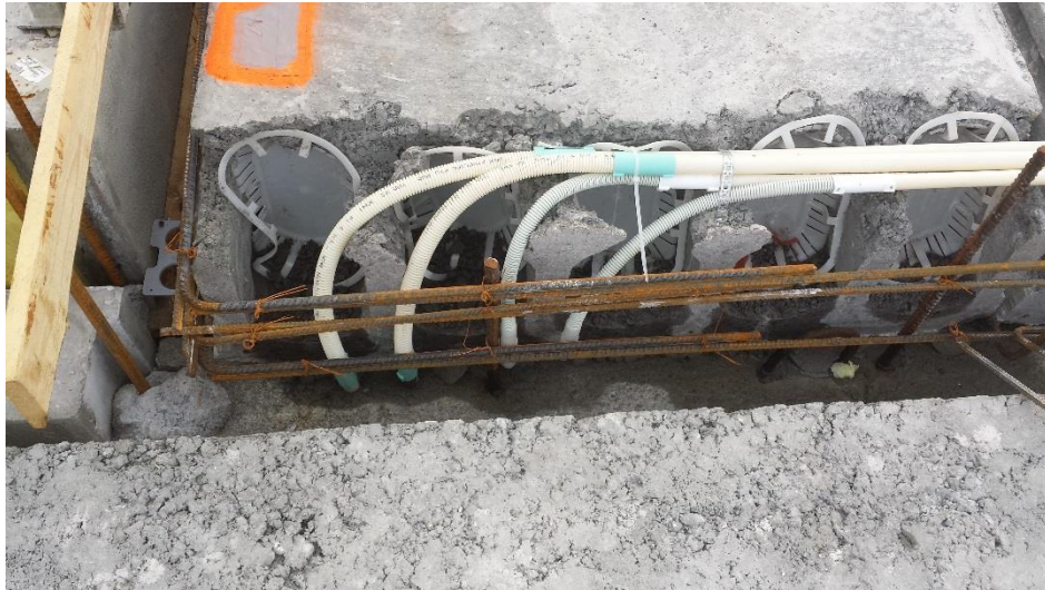
Kuva 11. Juotosvaluraudoitus ja sähköputkitus (kuva: Toni Aalto).
