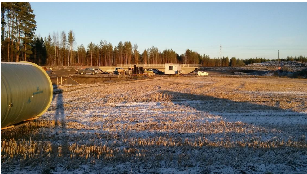
Kuva 5. Rautatien alitustunneli rakennusvaiheessa (kuva: Ari-Matti Lautamäki)
