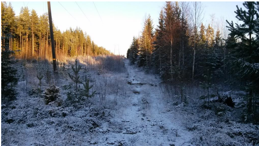
Kuva 4. Valokuva sähkölinjasta (kuva: Ari-Matti Lautamäki)
