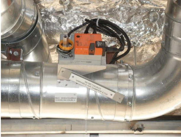
Kuva 3. VAV-säätöpelti spirokanavassa.
