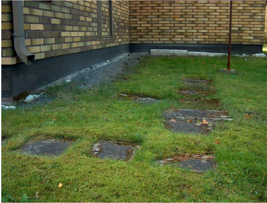
KUVA 3. Perustusten routaeristeet ja ympäröivän maapinnan kallistukset
