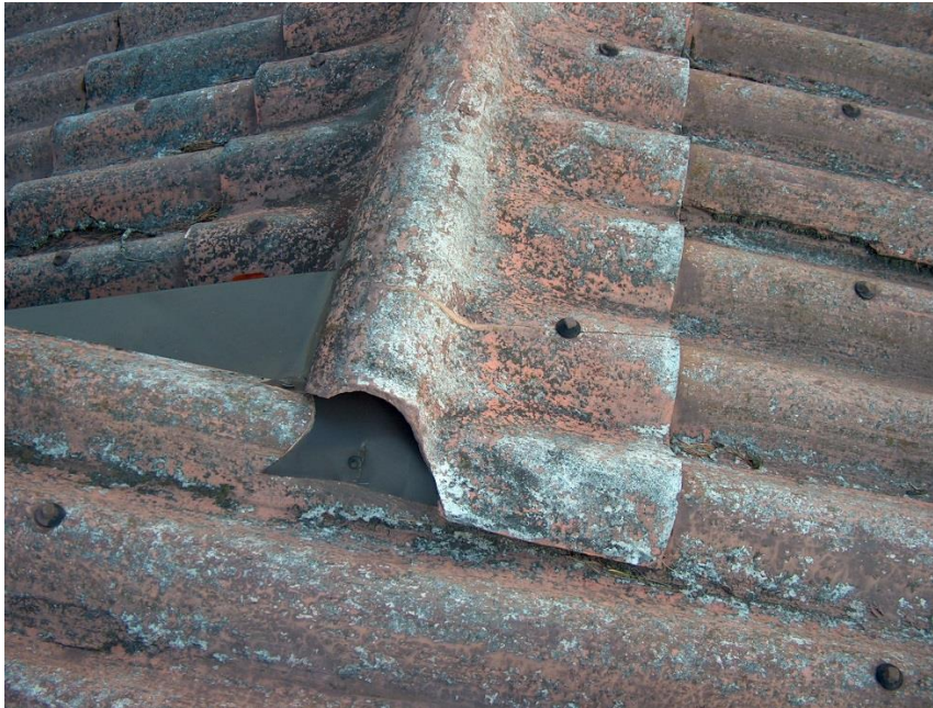
KUVA 7. Vesikaton korjaus lohjenneen palan kohdalta
