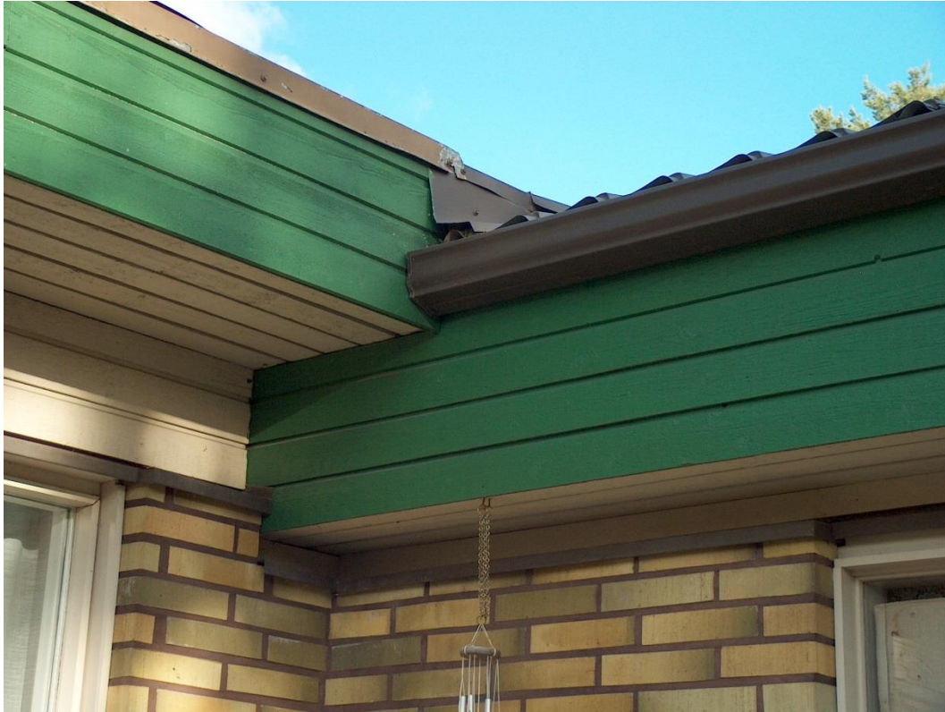
Räystäslaudoitukset ja autotallin katon liittymäkohta
