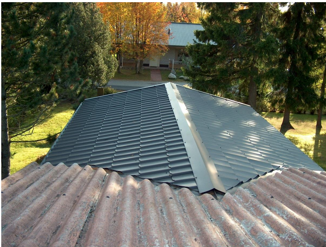
Autotallin korotettu vesikate
