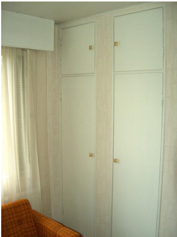
Makuuhuoneen ulkoseinää vasten oleva komero
