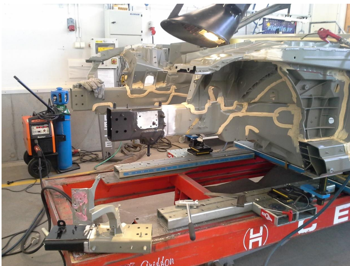
KUVA 36. Palkin etuosan vaihto hitsausliitoksella R231 SL-sarja (Kittelä 2013-5-15.)
