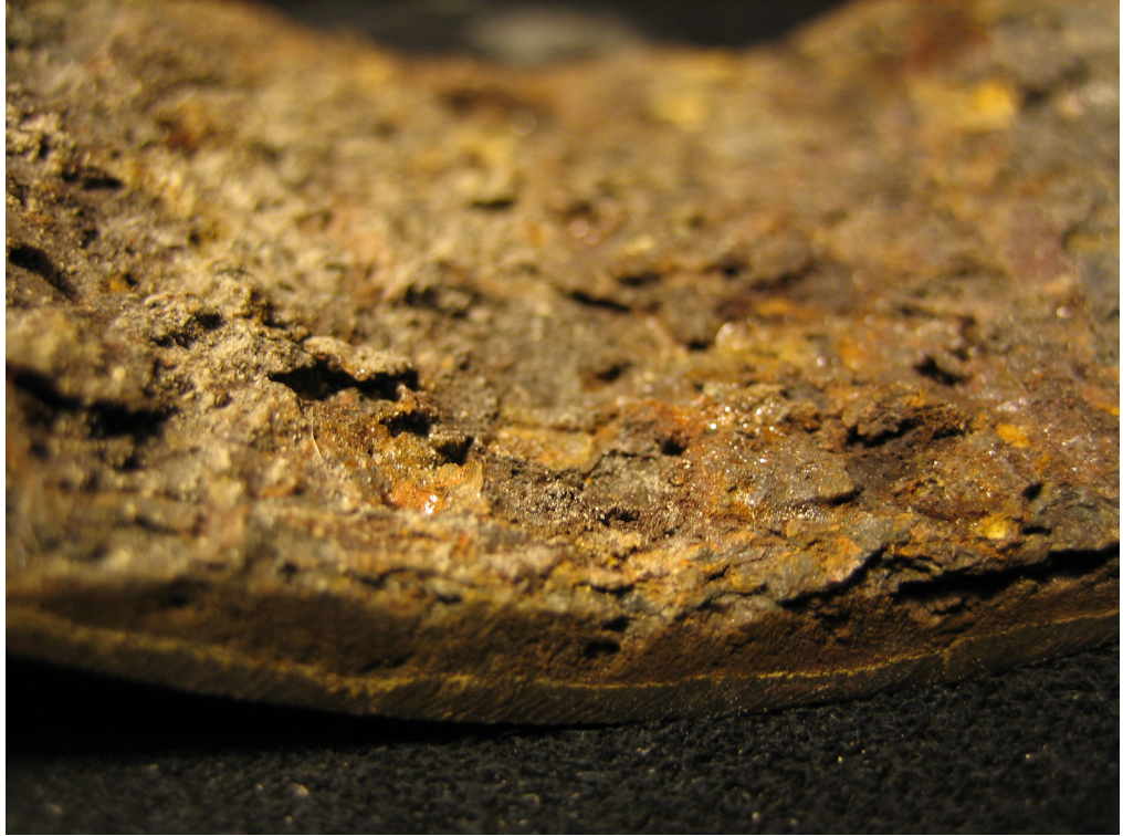
Kuva 7 Viemäriputken grafitoitumista, putki vuodelta 1950 (seinämän kokonaisvahvuus n. 5 mm)
