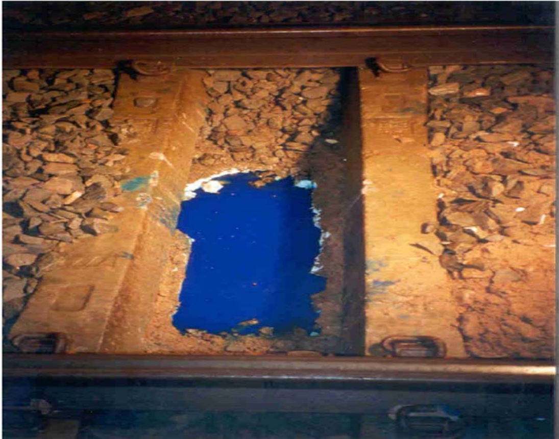
Kuva 7. Vesi keräytyy Tottolan tunnelin pohjalle (apuna käytetty sinistä väriainetta) (E. Mäkelä, henkilökohtainen tiedonanto 5.1.2015).
