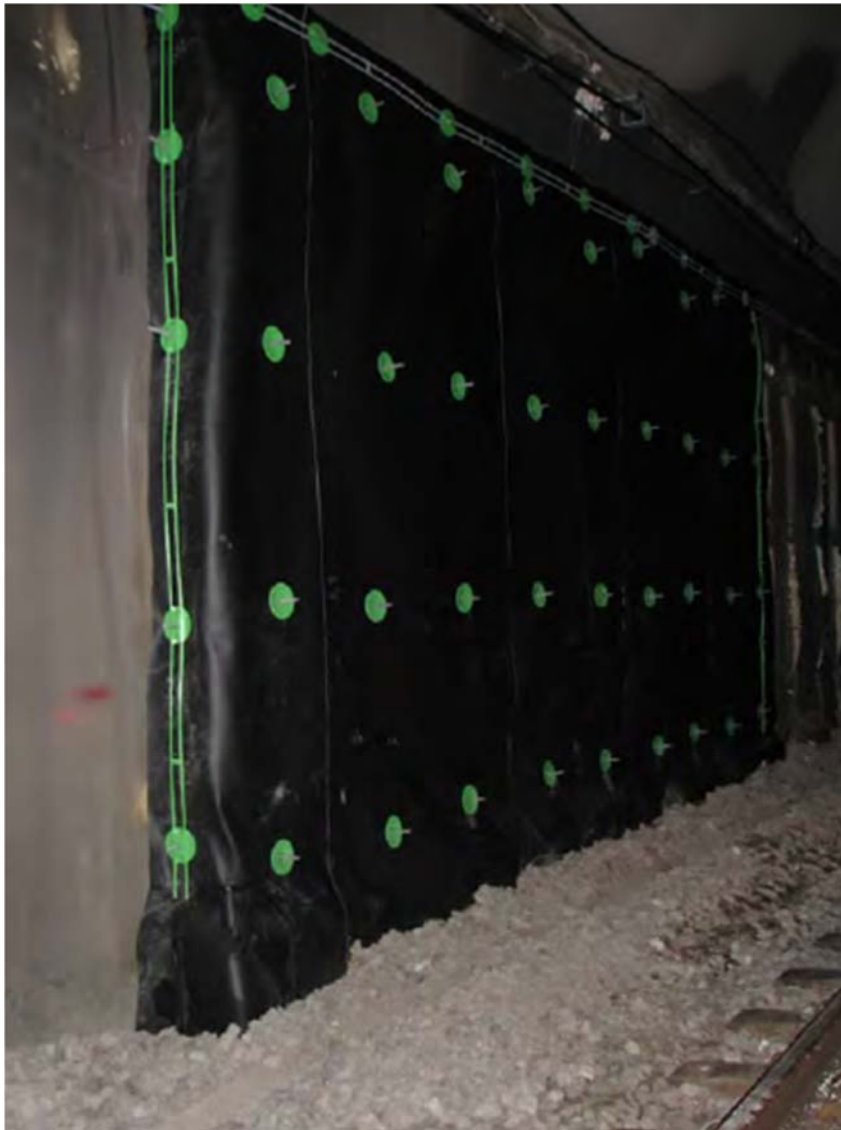
Kuva 11. Valmis membraanikoerakenne Tottolan tunnelissa (E. Mäkelä, henkilökohtainen tiedonanto 5.1.2015).
