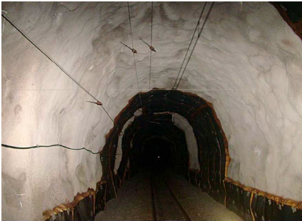
Kuva 2. Oikealla ja keskellä pelkkä lujiterappaus kallion pinnassa. Alhaalla sekä taaempaa on polyeteenilevyjä. (Ratahallintokeskus 2008.)
