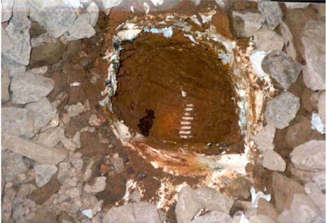
Kuva 8. Auki kaivettu salaojan kohta Tottolan tunnelissa (E. Mäkelä, henkilökohtainen tiedonanto 5.1.2015).
