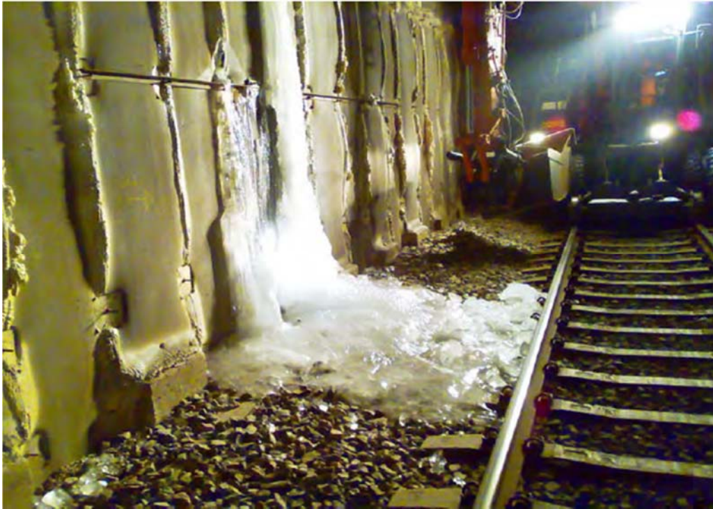
Kuva 12. Paannejäättä Tottolan tunnelissa koteloeristerakenteen kohdalla (VR-Track Oy 2012).
