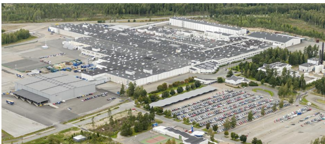
Kuva 8. VA:n tuotantolaitos ja HUB:in logistiikkakeskus (HUB logistics Oy 2015).
