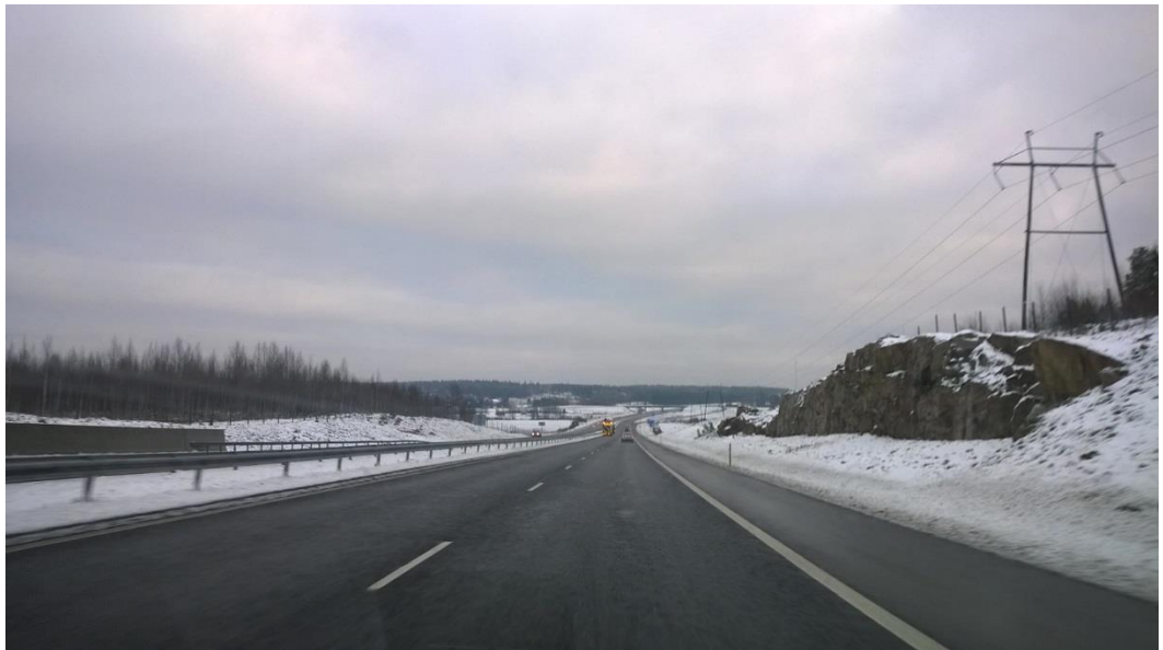
Kuva 8. Is hoitoluokan teillä liukkaudentorjunta on ennakoivaa. Kaikki jäätämistilanteet torjutaan ennakoivalla suolauksella. (Talja, 2014)
