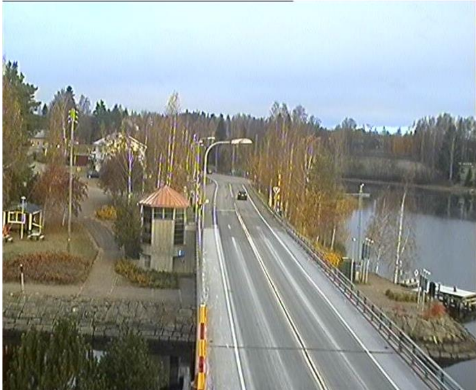
Kuva 17. Sillat jäähtyvät kahteen suuntaan sekä vesistö lisää kosteutta, minkä takia ne jäätyvät usein ensin. Visuveden silta k66, 17.10.2014. (Liikennevirasto)
