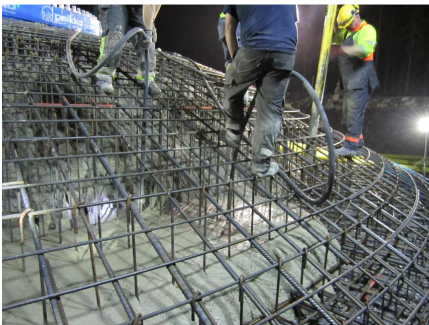
Figur 28. Här kan noteras hur betongmassan byggs upp till ett berg i kärnan som täcks lagervis ut mot fundamentets ytterkant. Tekniken går ut på att möta överkantsarmeringen på jämt avstånd till betongmassan. (Ralf Wasberg)
