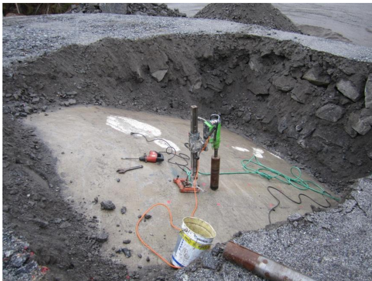
Figur 26. Före borrning rekognoserades armeringsjärnets position. Provborrningar gjordes för att säkerställa sig om betongens kvalitet i konstruktionen. (Ralf Wasberg)
