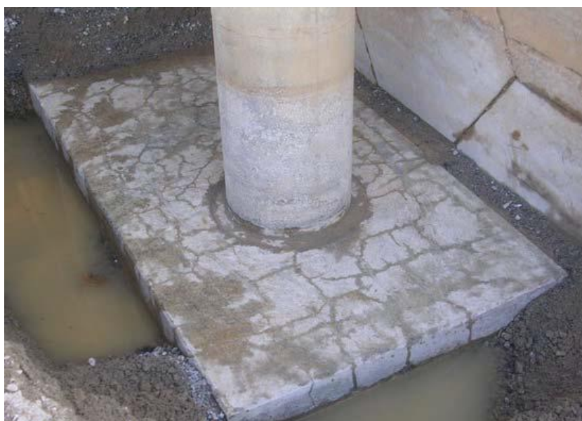
Figur 16. Sprickbildning på en sula som orsakats av försenad ettrignit bildning (Nanayakkara Anura u.å.)
