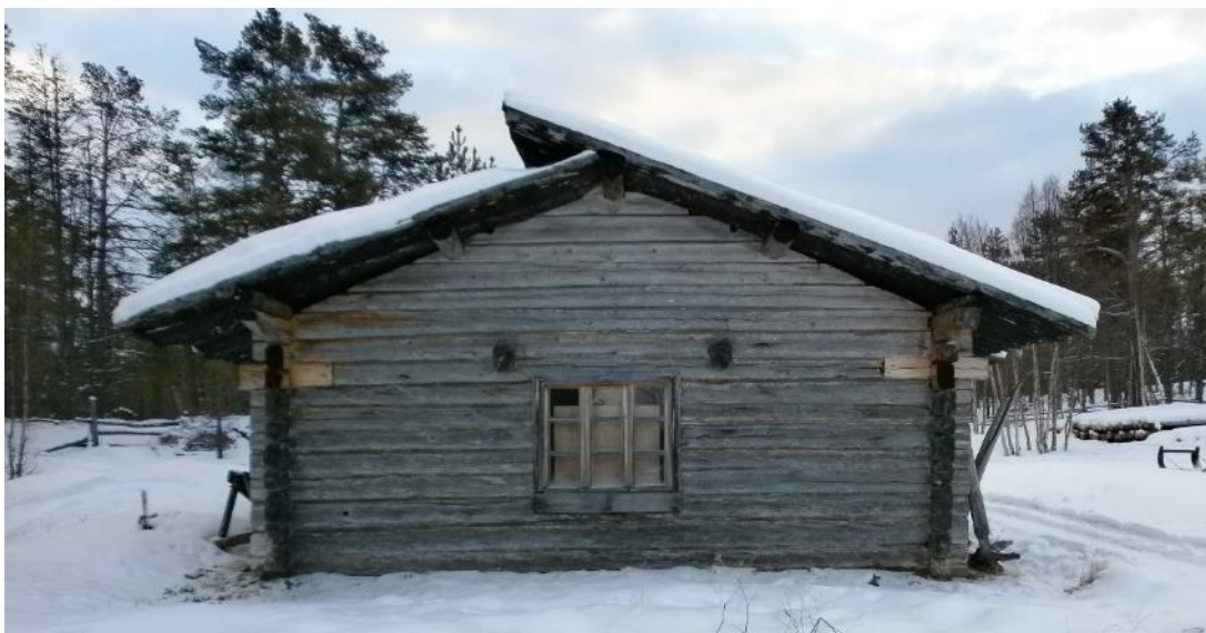
Kuva 4. Vanha kelleskatto. Kattokulmaa on muutettu aiemmissa korjaustöissä (Alexander Kopf).
