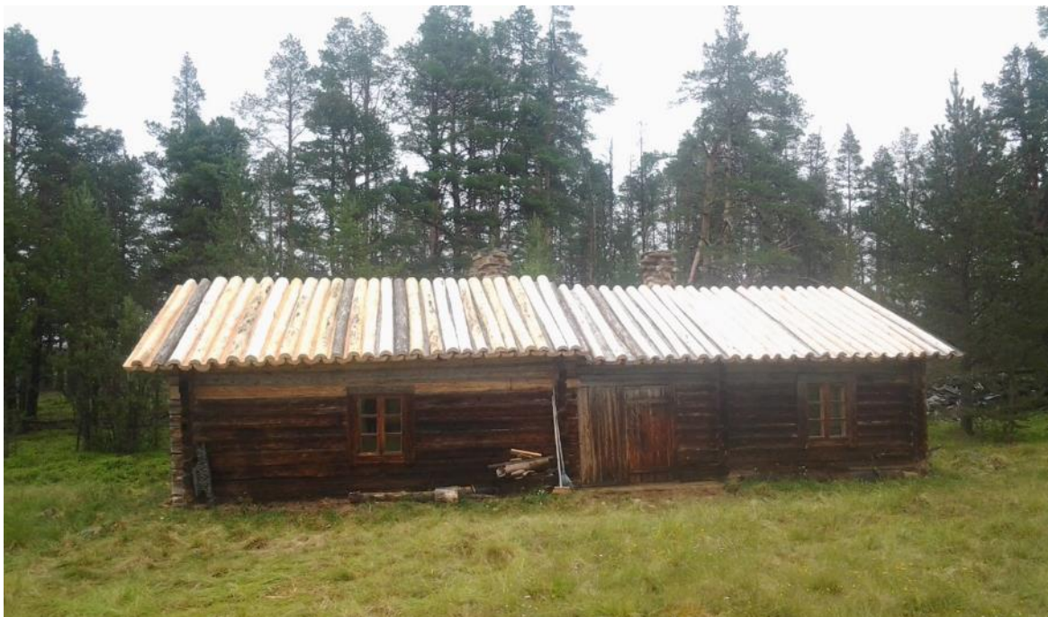
Kuva 16 Valmis katto ennen tervausta.
