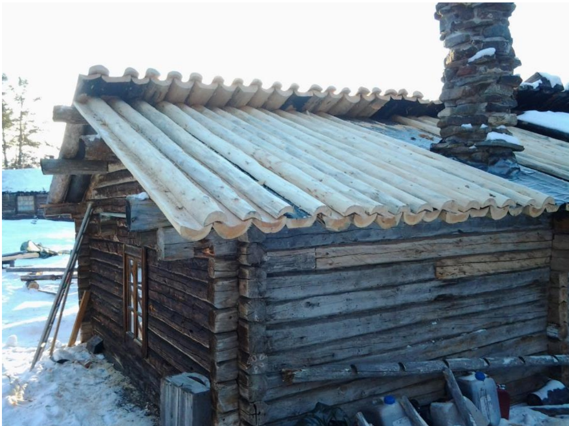
Kuva 14. Rakennuksen toinen pääty lähes valmiina. Savupiippu tiivistettiin lyjypellillä.
