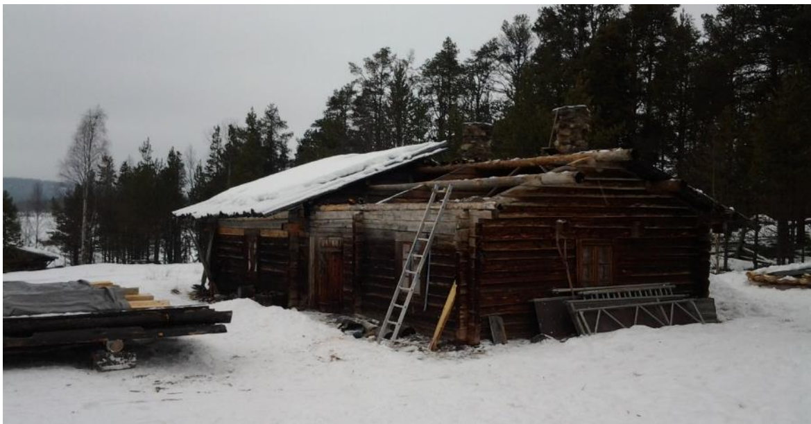
Kuva 10. Vanhan katon purkua.
