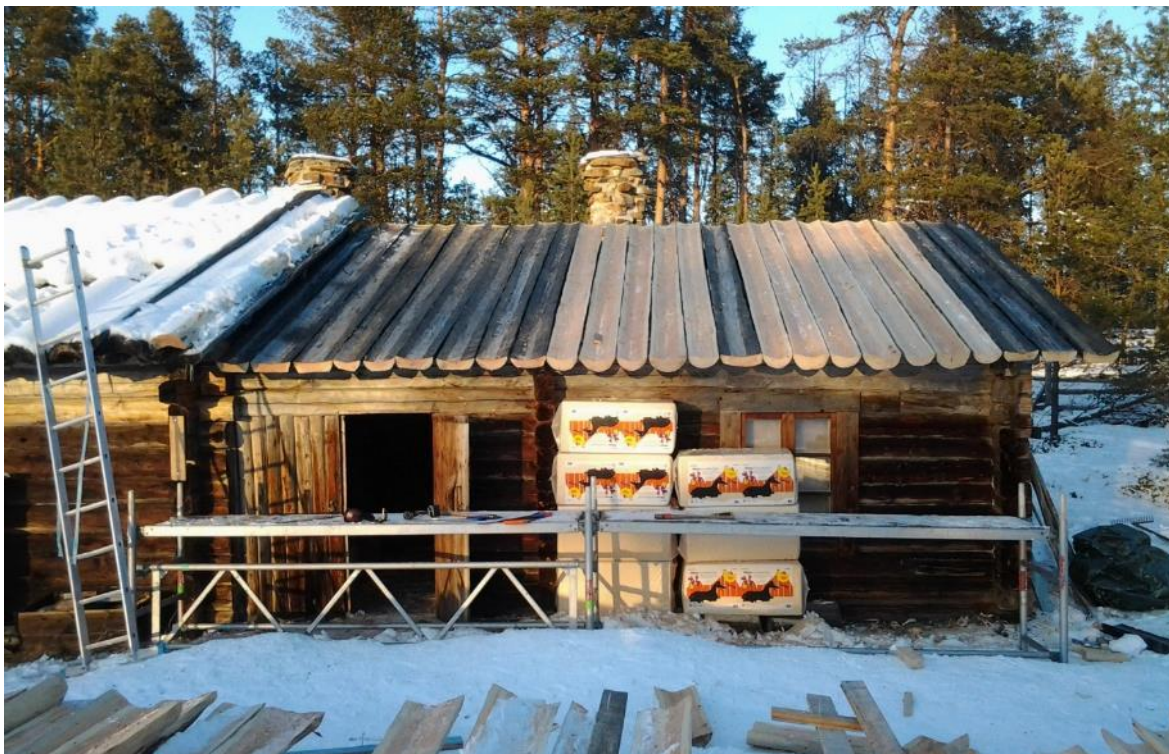
Kuva 12. Osa vanhoista kelleksistä voitiin säästää. Aluskellekset asennetaan tyvi-latva vuorottelulla.
