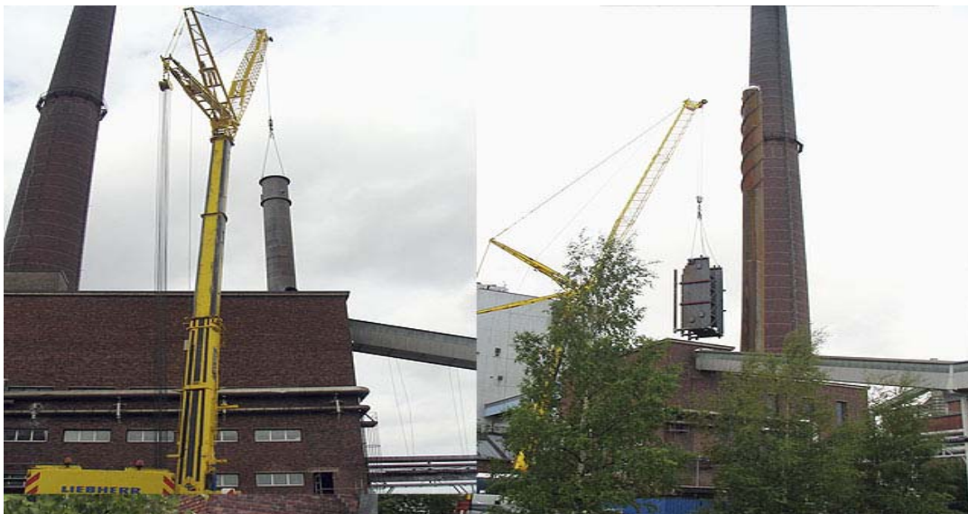
Kuva 4. Apukattilan rakennusvaiheen kuvia kesältä 2007 (kuvannut Markku Santikko)
