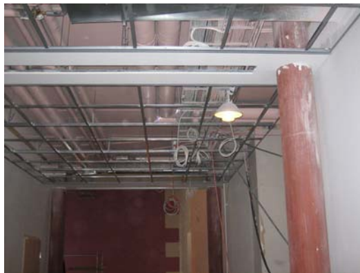
Kuva 1. LVIS-laitteistot alakattorungon yläpuolella.
