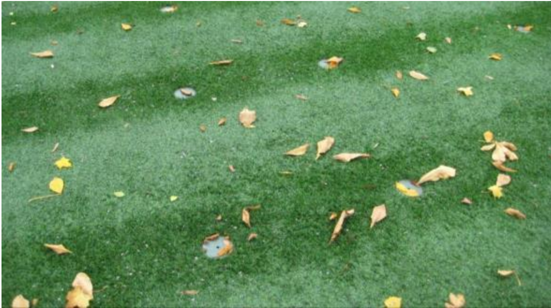
Kuva 17. Laikunlavan katsomon tekonurmessa on maahan upotettu penkeille paikat. Penkkien kohdalla tekonurmi on tummempi, koska penkit ovat suojanneet tekonurmea auringonvalolta. (Kirsi Paakkunainen 2014)
