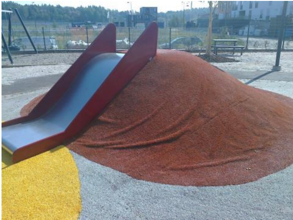
Kuva 16. Rinteeseen asentaminen siististi voi olla työlästä ja ryppyjä jää helposti. (Jäämestarit Oy)
