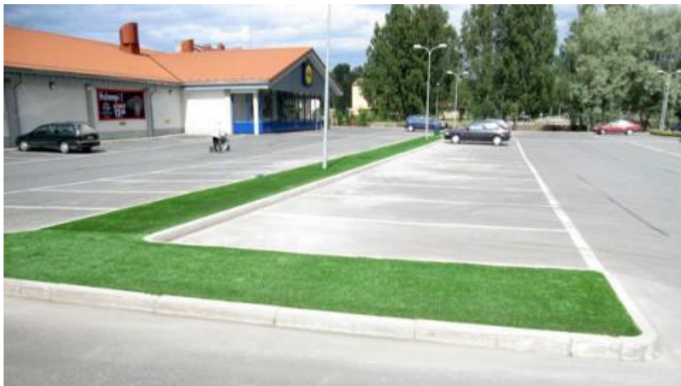
Kuva 7. Tekonurmea on asennettu Äänekosken Lidlin parkkipaikalle. Liikennealueilla voidaan käyttää käytettyä tekonurmea. (Saltex Oy)
