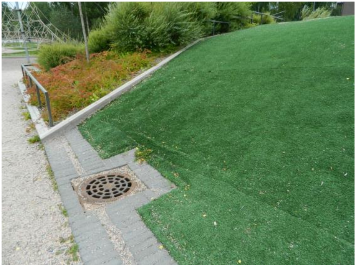
Kuva 13. Lähikuva mäestä, joka on päällystetty tekonurmella Kirkkojärven koulun pihalla. Tekonurmi rajautuu puulankkuihin ja betonikiviin. Tekonurmi on asennettu mäensuuntaisesti. (Ella Uppala 2013)
