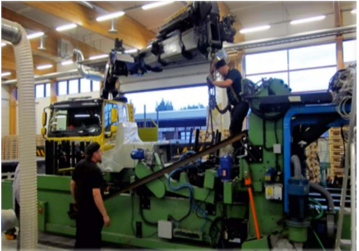
Kuvio 4. Linjansiirtotyöt käynnissä. (Pinomatic Oy, [Viitattu 20.3.2014].)
