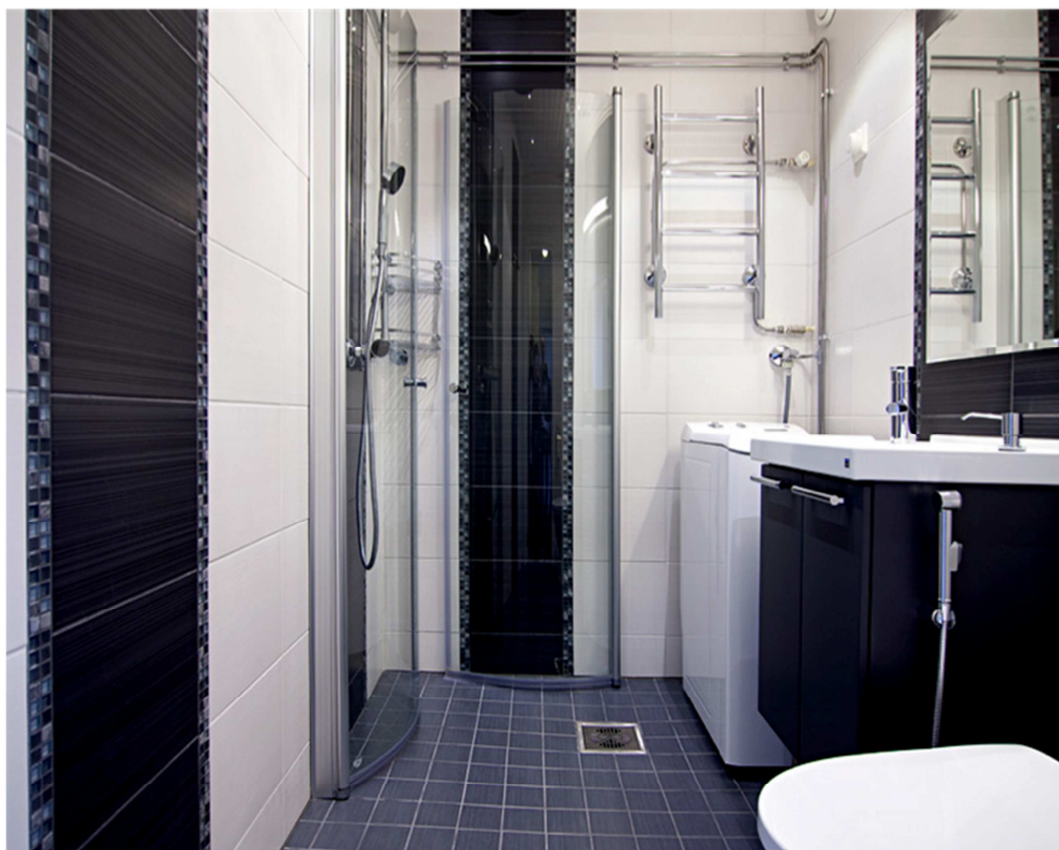
Kuva 6. Kylpyhuone kromatulla putkella (Remonttiparkin www-sivut 2014)
