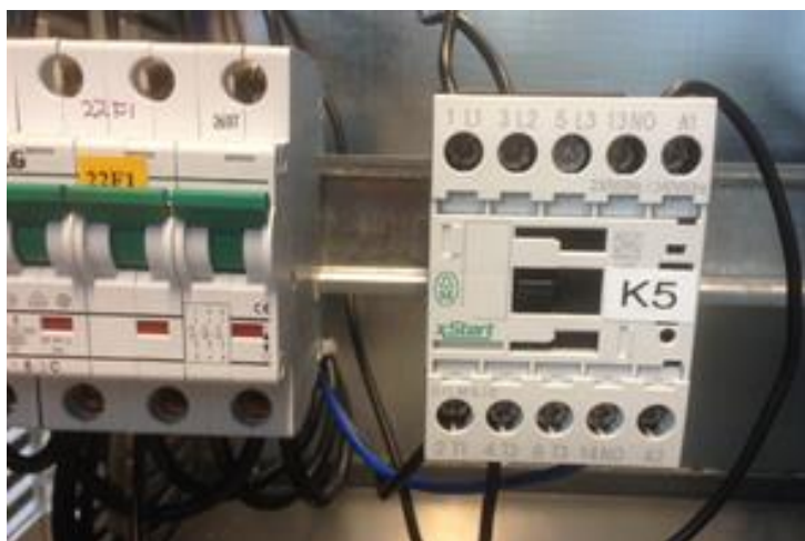
KUVA 32. Kontaktoriohjaus, kuva asennustilanteesta
