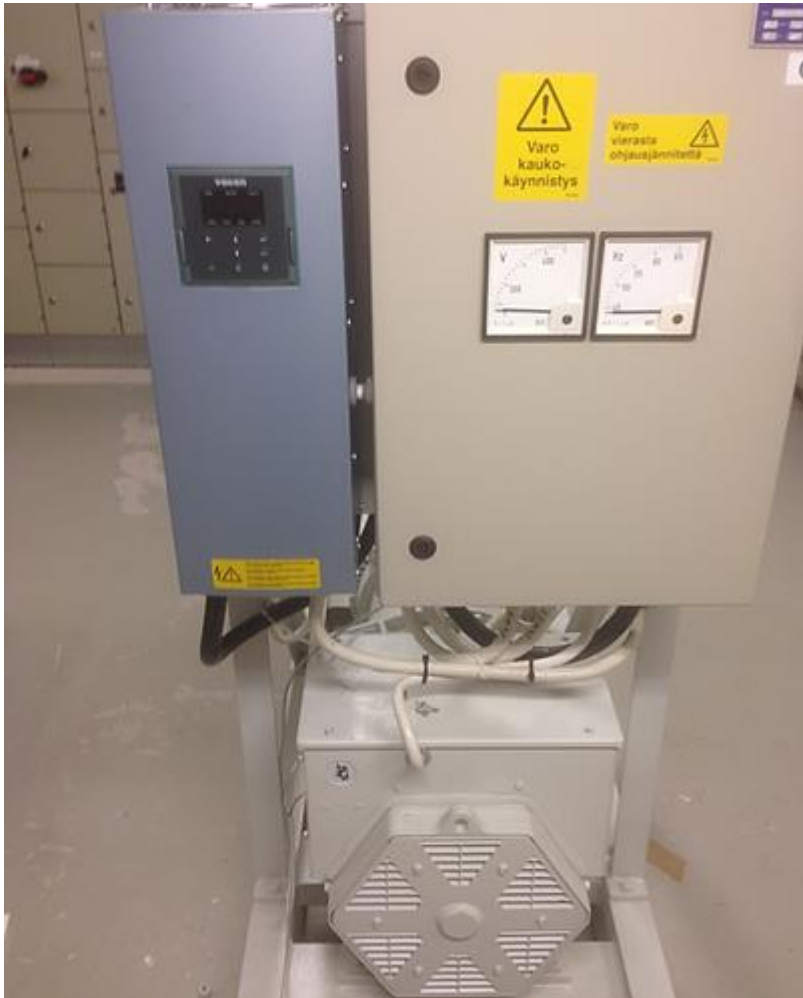
KUVA 16. Generaattori G1 ja sen voimakonetta ohjaava Vacon CX –taajuusmuuttaja
