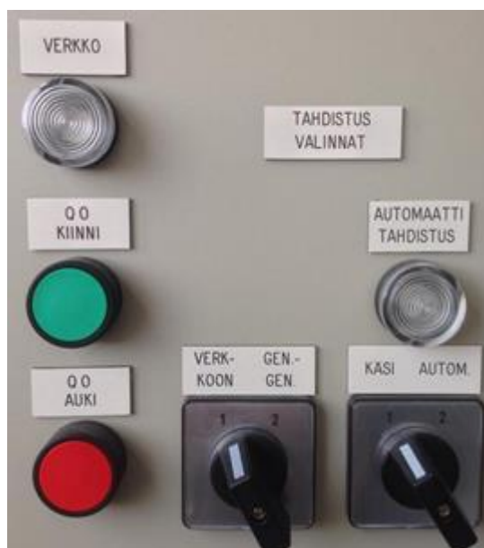
KUVA 19. Verkkokatkaisijan Q0 ohjaaminen ja tahdistuksen valinta
