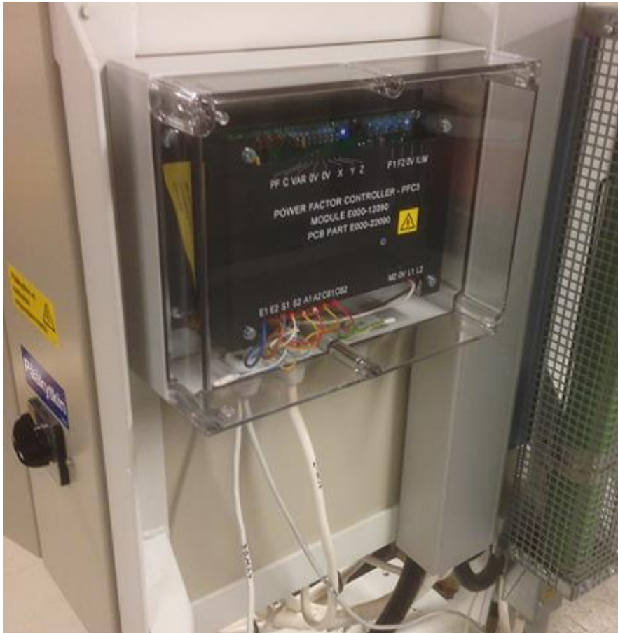
KUVA 41. Tehosäädin koteloituna ja asennettuna paikoilleensa
