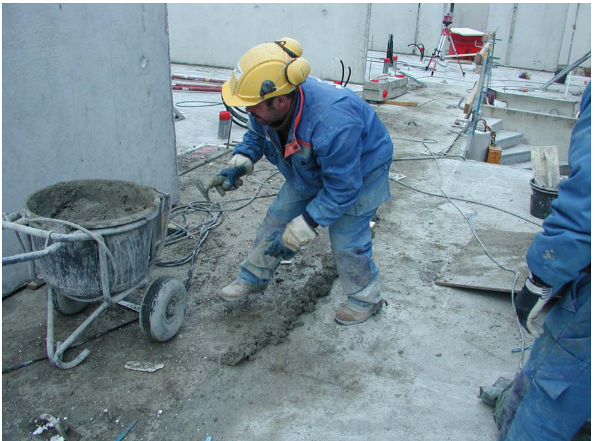
Kuva 14. Väliseinäelementin vaakasauman juotosta.
