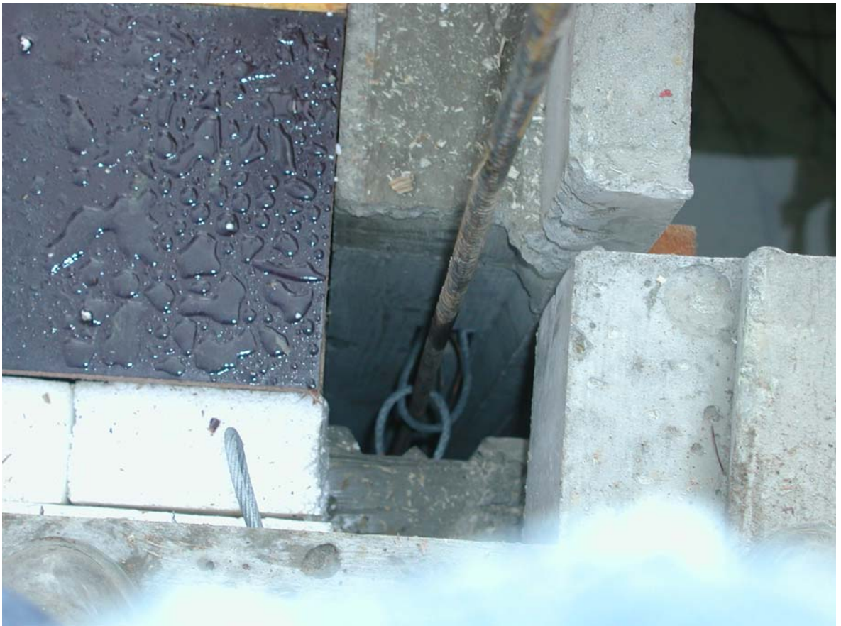
Kuva 15. Pystyteräs asennetaan vaijerilenkkien väliin.
