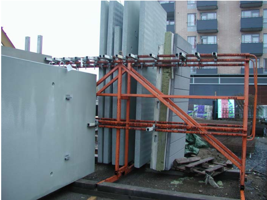
Kuva 4. Seinäelementtien välivarastointipaikkana käytetään vakkia.
