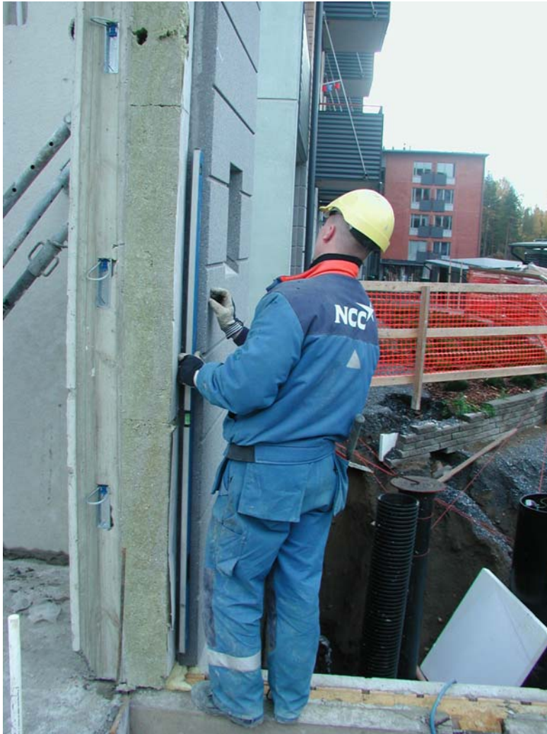
Kuva 11. Suoruus tarkastetaan vatupassilla.
