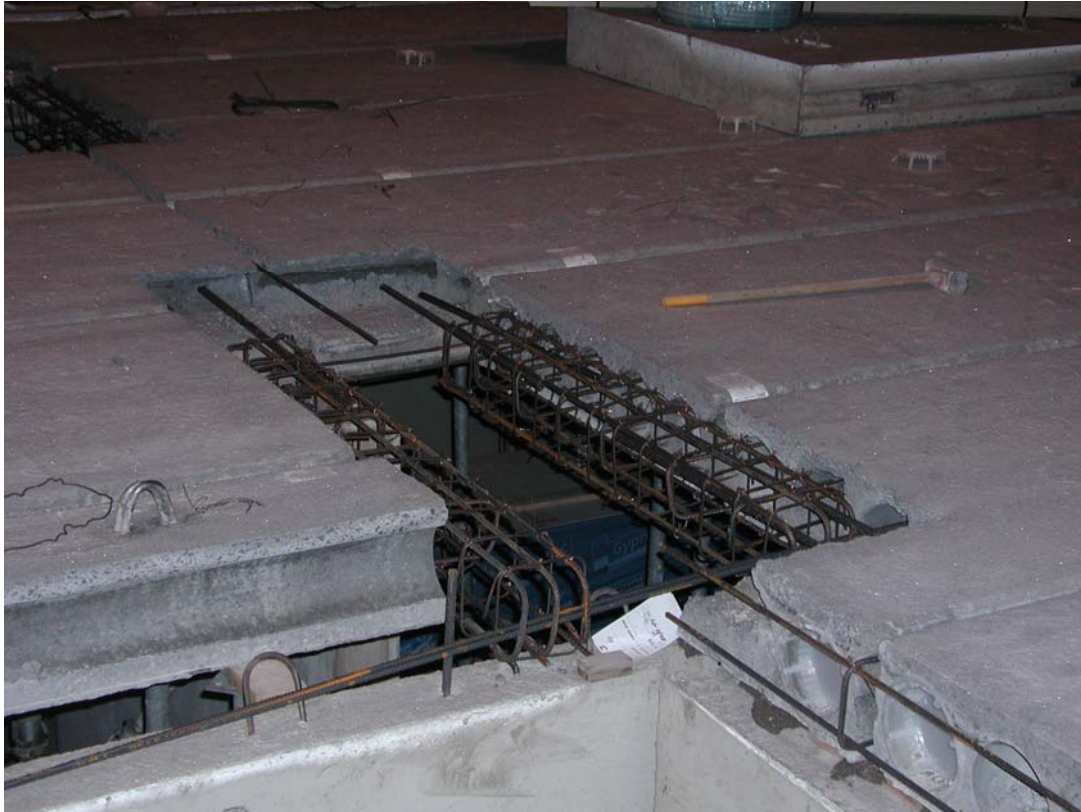
Kuva 20. Elpo-hormien kohta on raudoitettu laatastossa. Reunoilla olevat laatat kantavat keskimmäistä laattaa.
