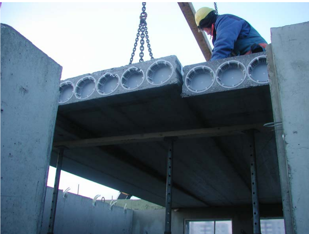
Kuva 4. Ontelolaatan asennusta väliaikaisten tukien päällä elpo-hormin kohdalla.
