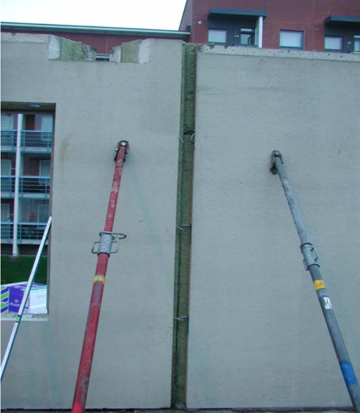
Kuva 5. Ulkoseinäelementit tuettu tönäreillä.
