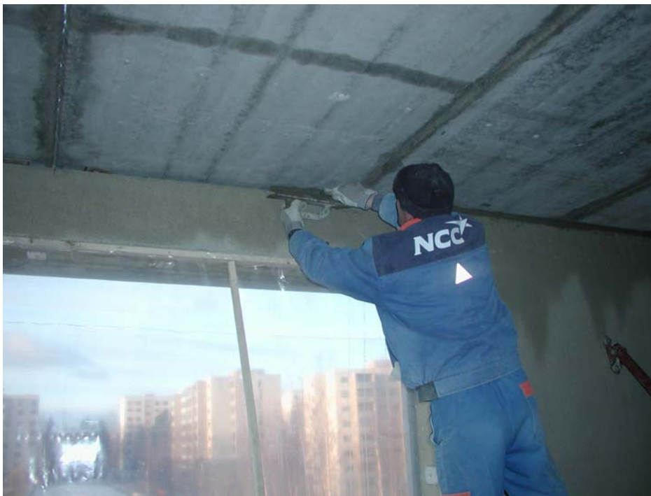
Kuva 23. Ontelolaatan alapuolisen sauman betonointi.
