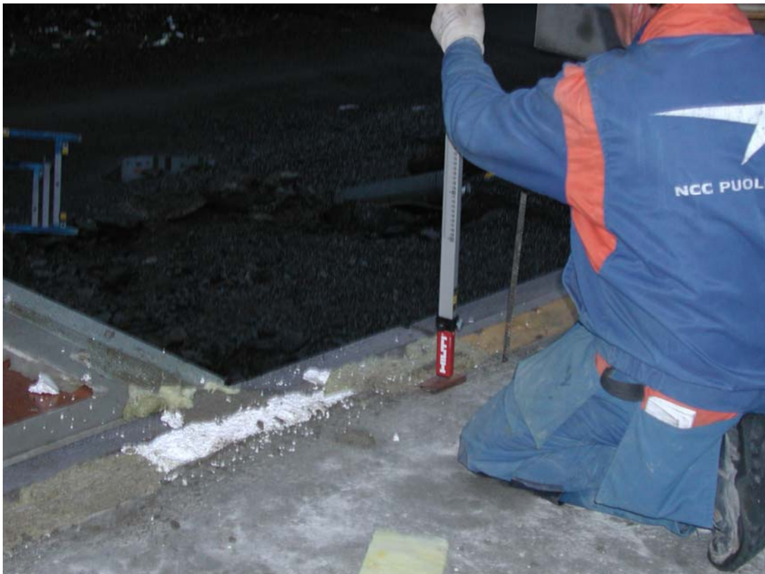
Kuva 9. Ulkoseinäelementtien korkojen mittausta.
