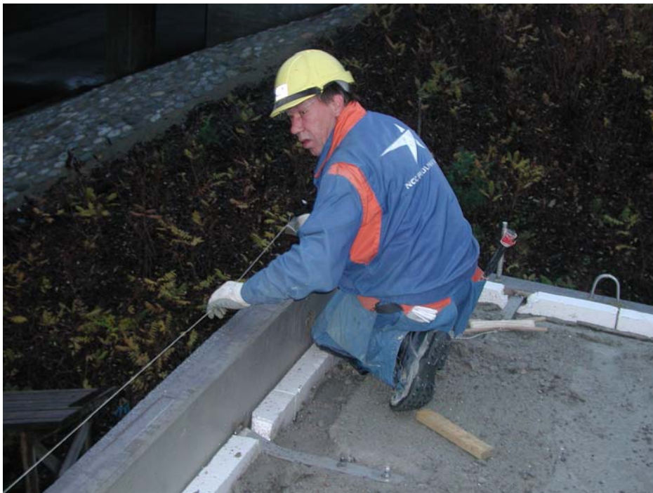
Kuva 13. Seinälinjan suoruus täytyy tarkistaa.
