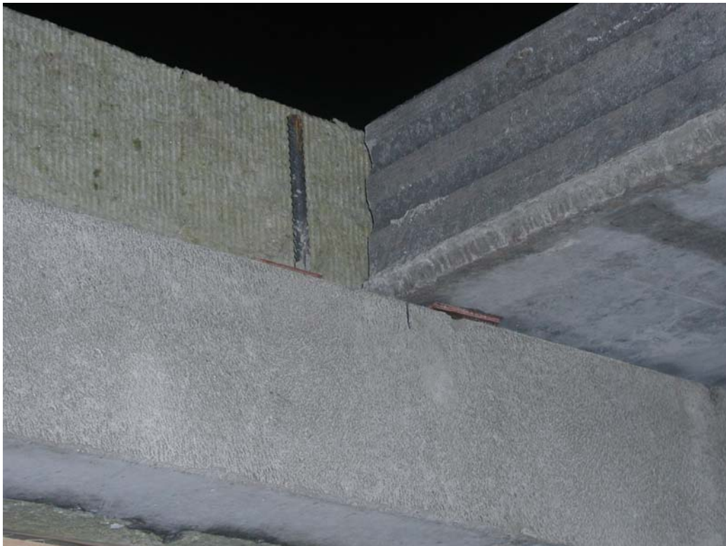
Kuva 17. Vanerilappuja asennetaan kaksi ontelolaattaa kohden.
