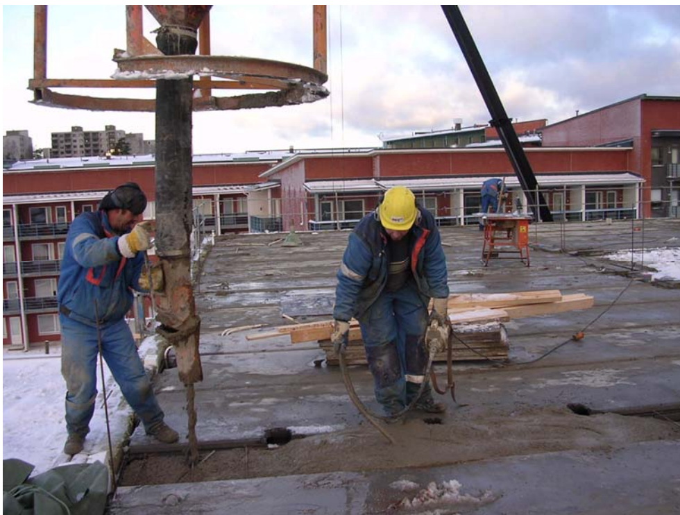
Kuva 21. Paikallavalu kaistan betonointi.
