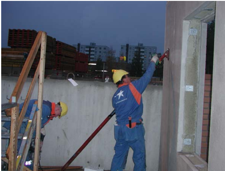
Kuva 5. Elementtituen yläpäähän kiinnitys.
