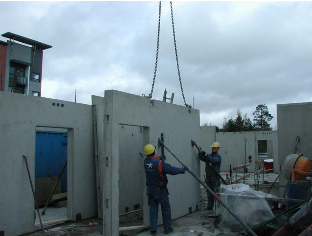
Kuva 3. Väliseinäelementin asennusta.
