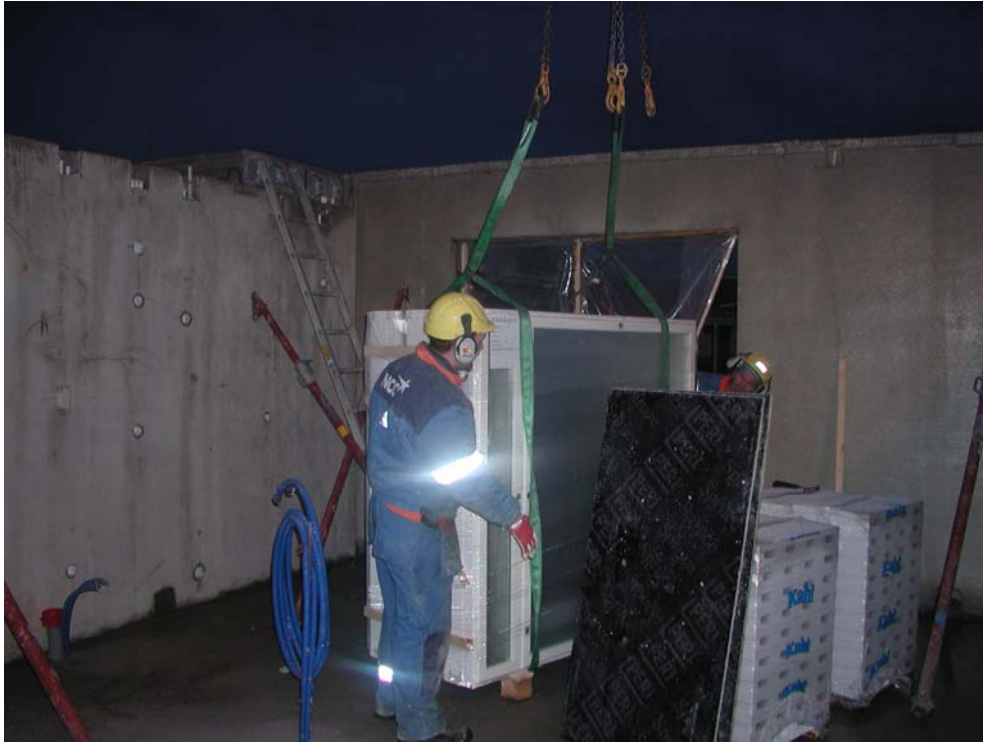
Kuva 6. Rungon valmistusvaiheessa ikkunat nostetaan kerroksiin.
