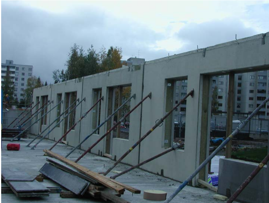
Kuva 12. Seinälinjan valmistuttua elementtien keskinäinen suoruus ja korkeusasema mitataan.
