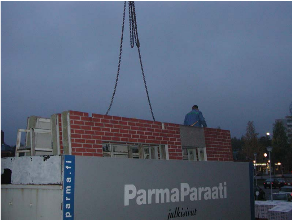
Kuva 1. Ulkoseinäelementtien nostoa.
