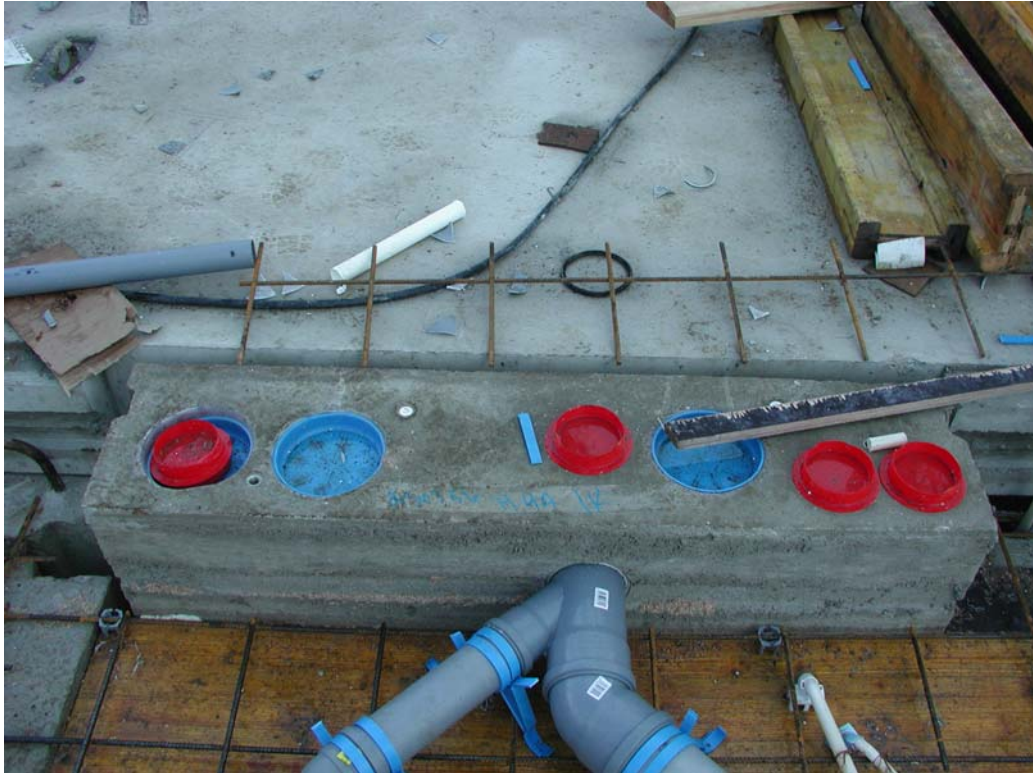
Kuva 26. Tulpat on muistettava poistaa ennen seuraavan elementin asentamista.
