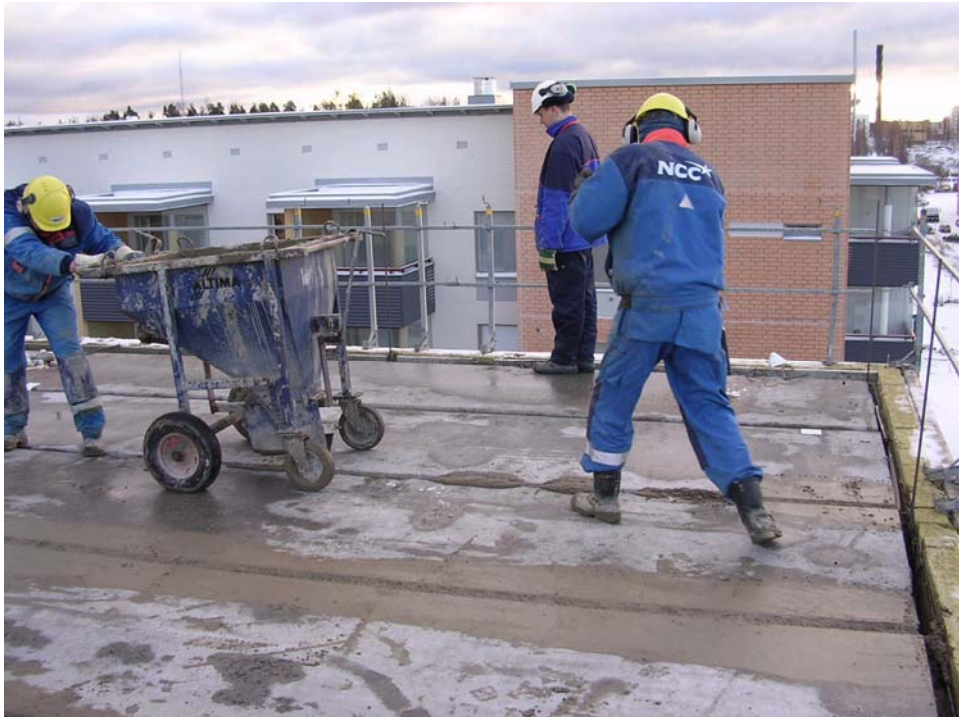
Kuva 22. Nostoastiaa ohjataan käsin holvilla ja samaan aikaan sauman päältä vedetään lastalla, jotta betoni kulkeutuisi tiiviisti saumoihin.
