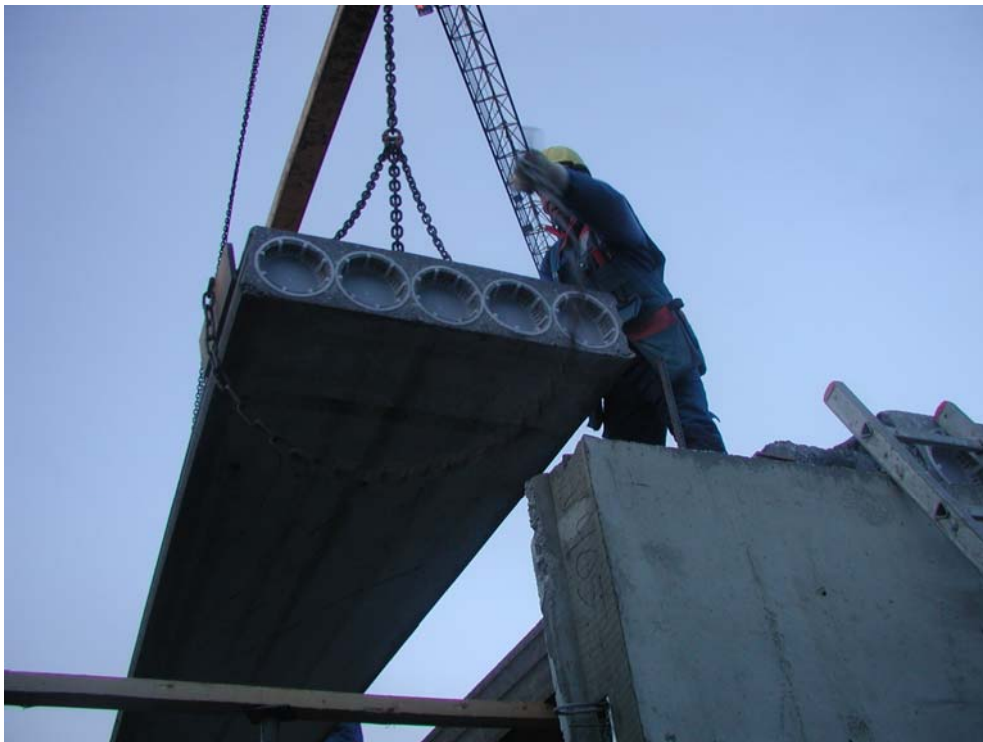
Kuva 18. Ontelolaatan asennusta. Varmuusketjut kulkevat elementin alapuolella.
