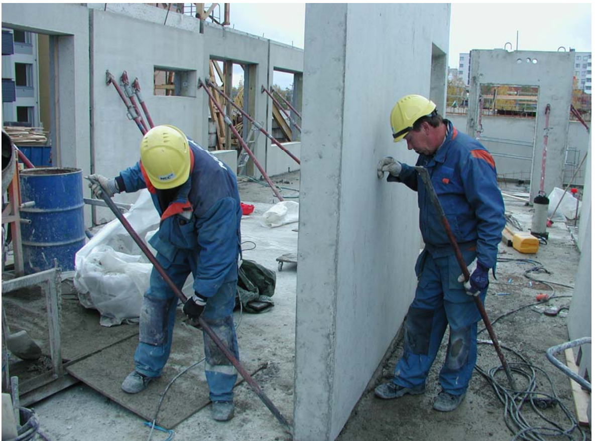
Kuva 10. Väliseinäelementin asennusta.
