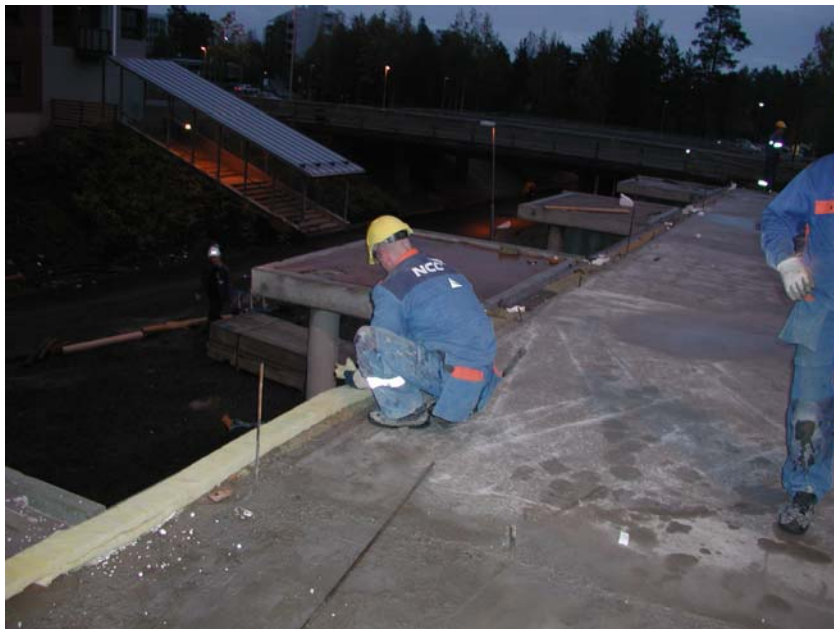
Kuva 8. Villakaista asennetaan edellisen elementin päälle. Kaistan pysyvyys varmistetaan nauloilla tai muilla vastaavilla tavoilla.
