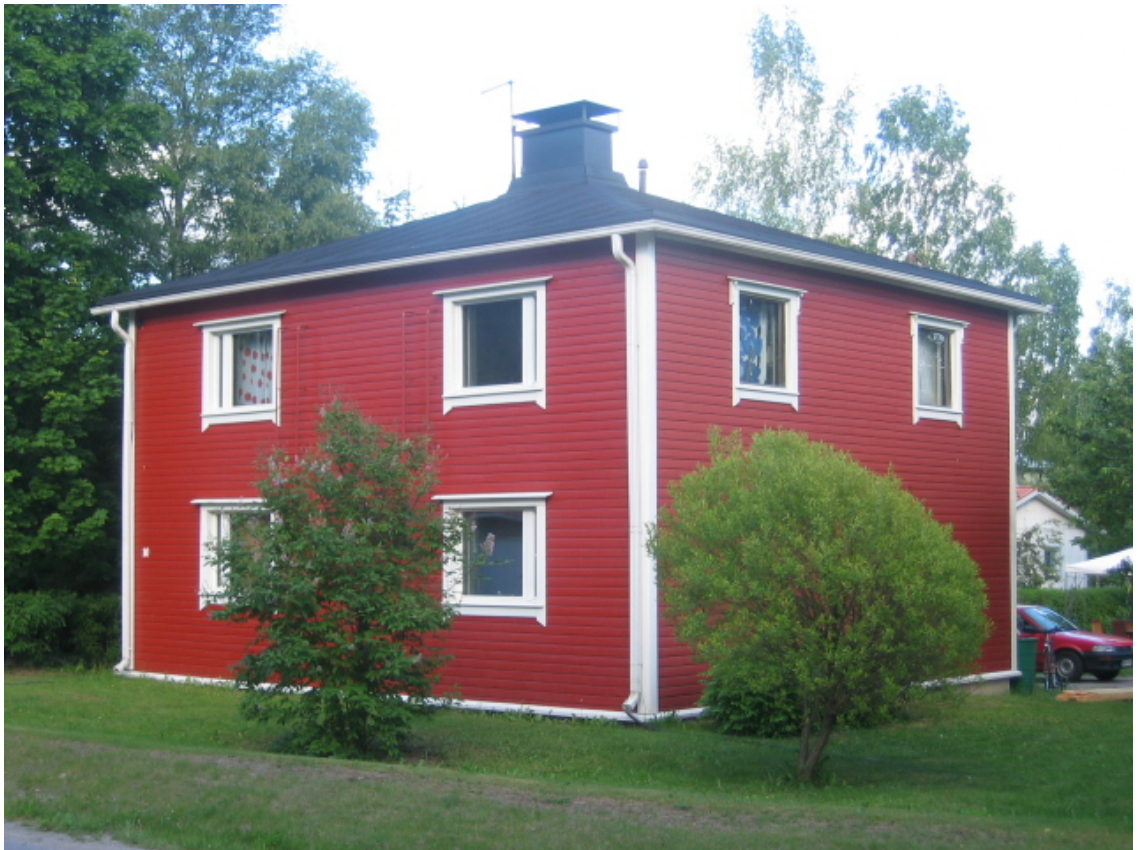
Kuva 2. Rakennus lounais-luode suunnasta.
