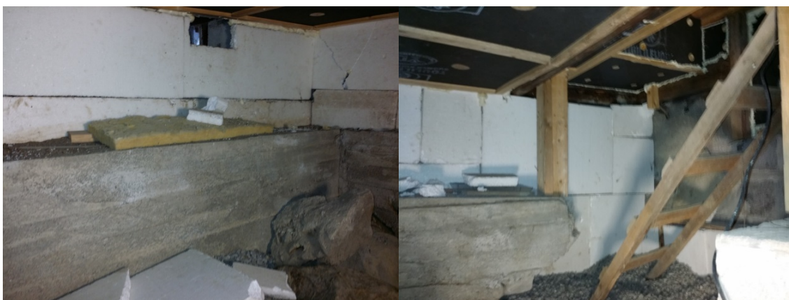
Kuvat 14 ja 15. Tukimuurirakenne kellarissa.
