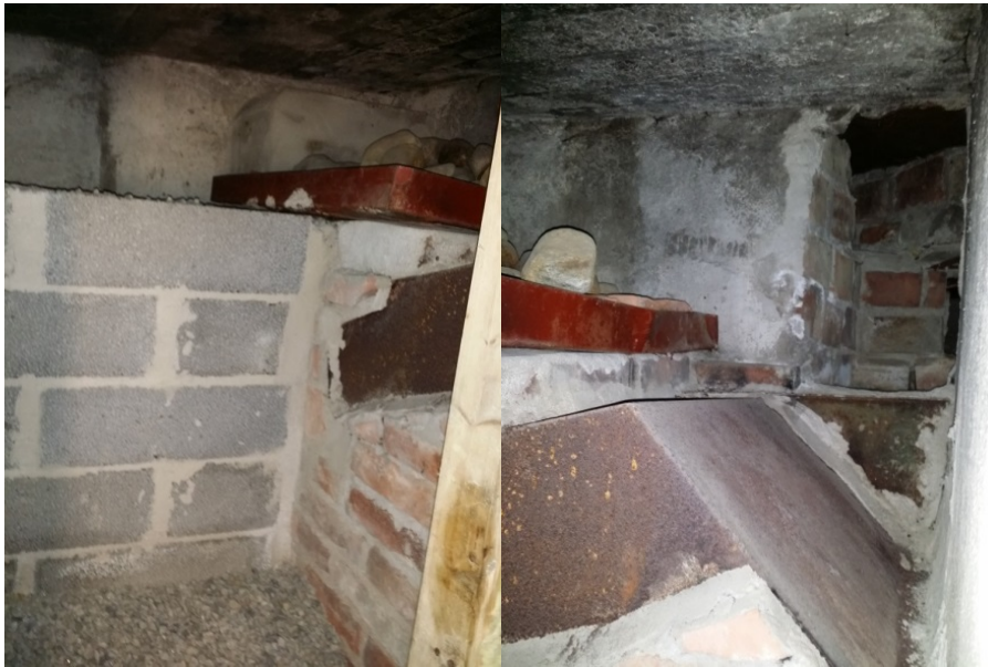
Kuvat 5 ja 6. Betonialapohjan aiempi lämmitysjärjestelmä sekä lämpöhormi, joka menee betonikuorikerroksen väliin.
