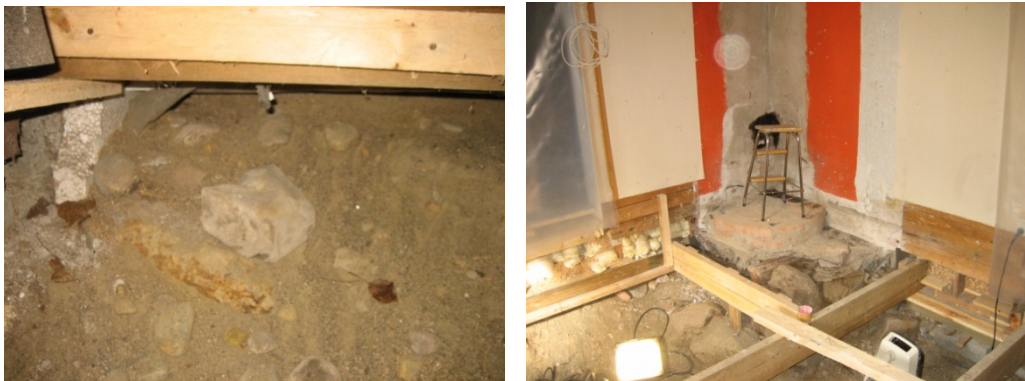
Kuvat 7 ja 8.. Laatta-alapohjan alla oleva maa-aines.
