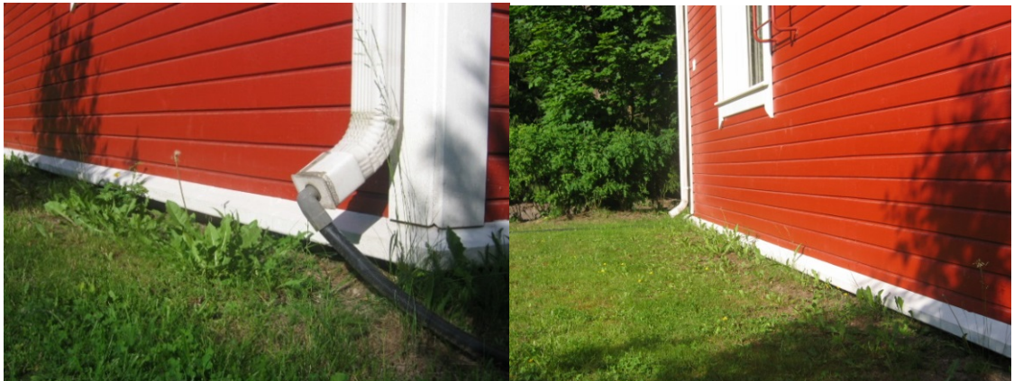
Kuvat 9 ja 10. Nurmialue on perusmuuriin asti sekä maanpinnan kallistukset rakennukseen päin. Vedenohjaus syöksytorvessa putken avulla.
