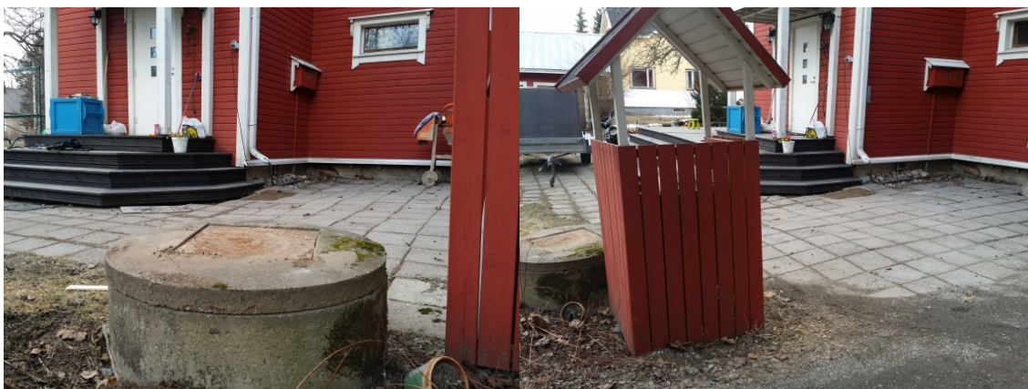
Kuvat 16 ja 17. Pintamaat ulkopuolella talouskellarin osuudella.
