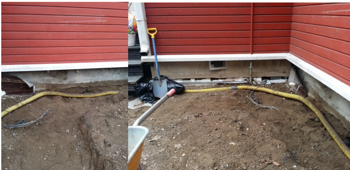
Kuvat 12 ja 13. Vanhat salaojaputket.
