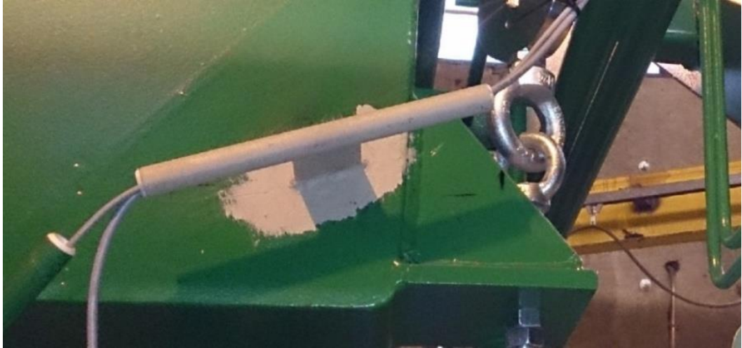
Kuva 2. Jälkikäteen hitsattu ja pohjamaalattu asennusputki.
