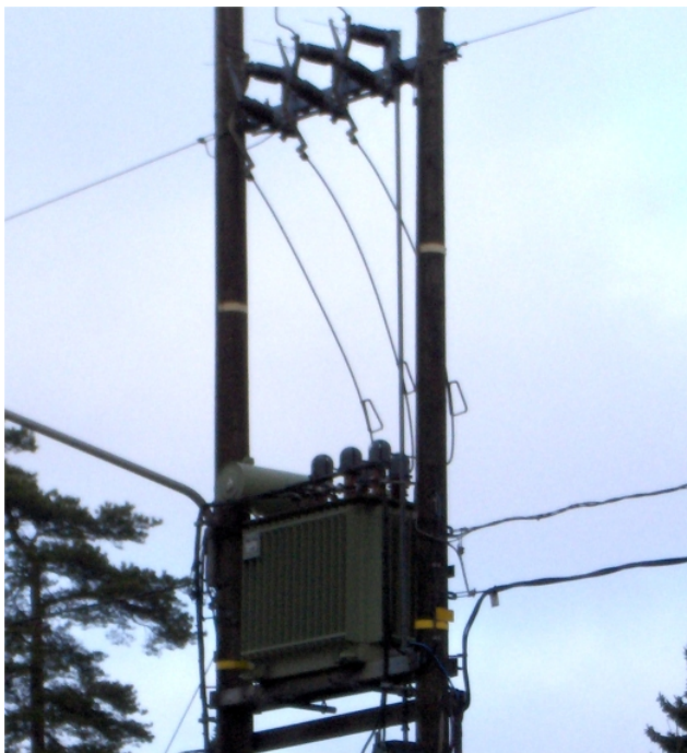
Kuvio 1: Tyypillinen II-pylväs muuntamo (Järvi Seppo, Sähkölaitostekniikka opintojaksoson koulutusmateriaali 2007)
