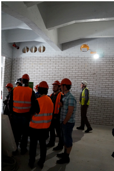
Kuva 30. Yleisopetustila vielä rakennusvaiheessa.
