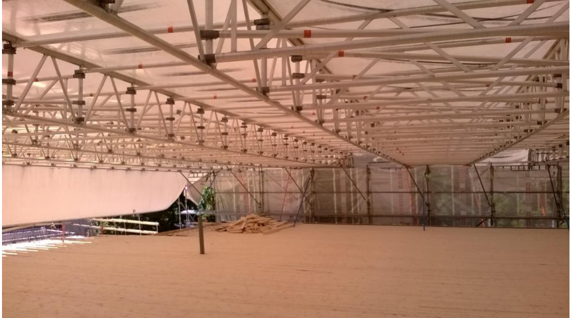
Kuva 23. Vesikaton puutyöt sääsuojan alla
