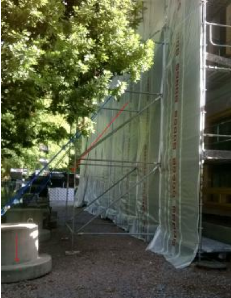
Kuva 22. Julkisivutelineen kiinnitys betonipainoihin.
