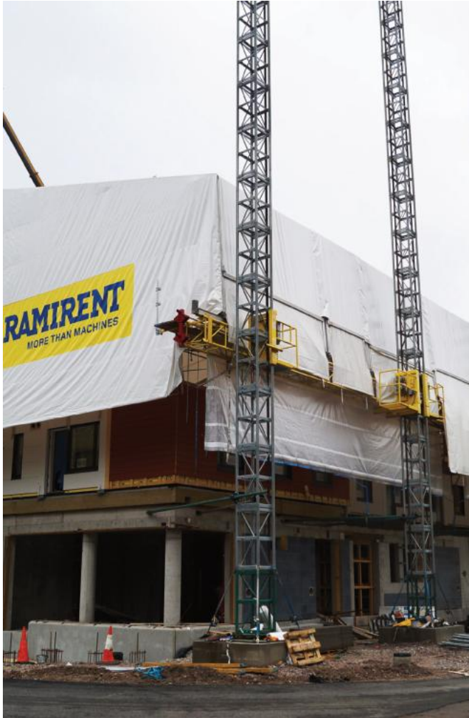
Kuva 24. Rungon pystyttäminen sääsuojan alla.
