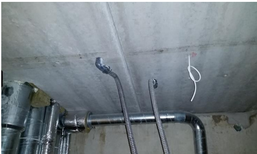
Kuva 36. Ontelon kuivaus työmaalla
