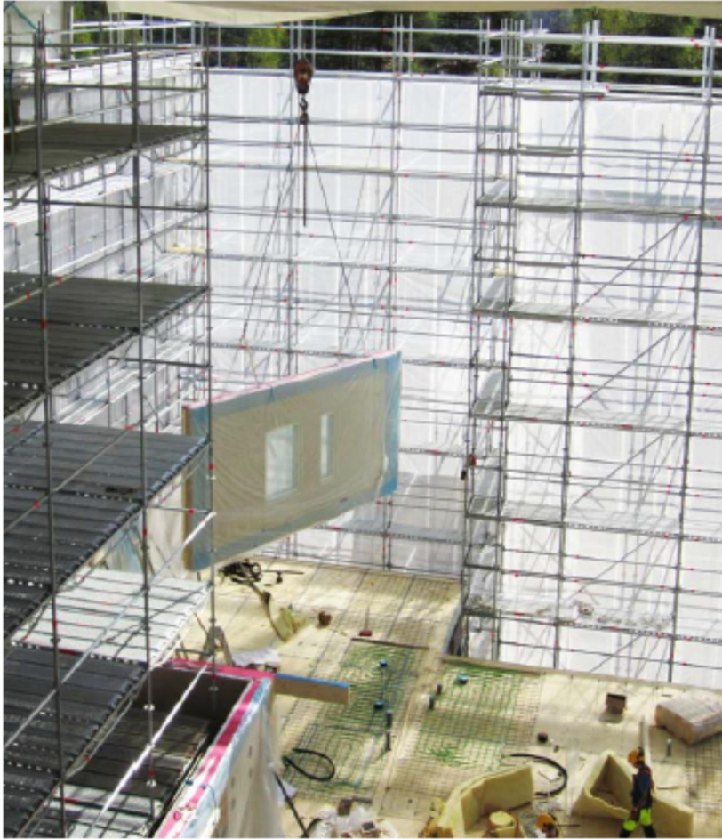
Kuva 25. Elementtirakentamista sääsuojan alla (25,S.1)
