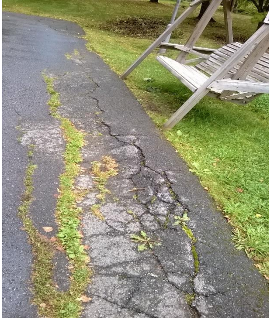
Kuva 5. Routavauriot asfaltissa
