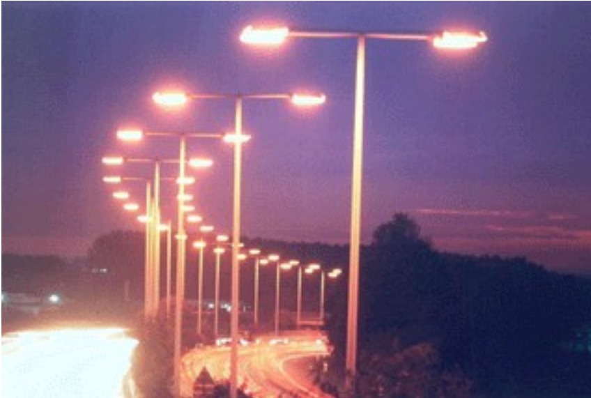
Kuva 4.8 Moottoritienvalaistus suurpainenatriumlampulla /o/
