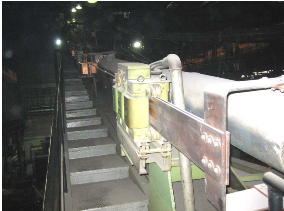
Kuva 6. Lämmitysputki ja muuntaja
