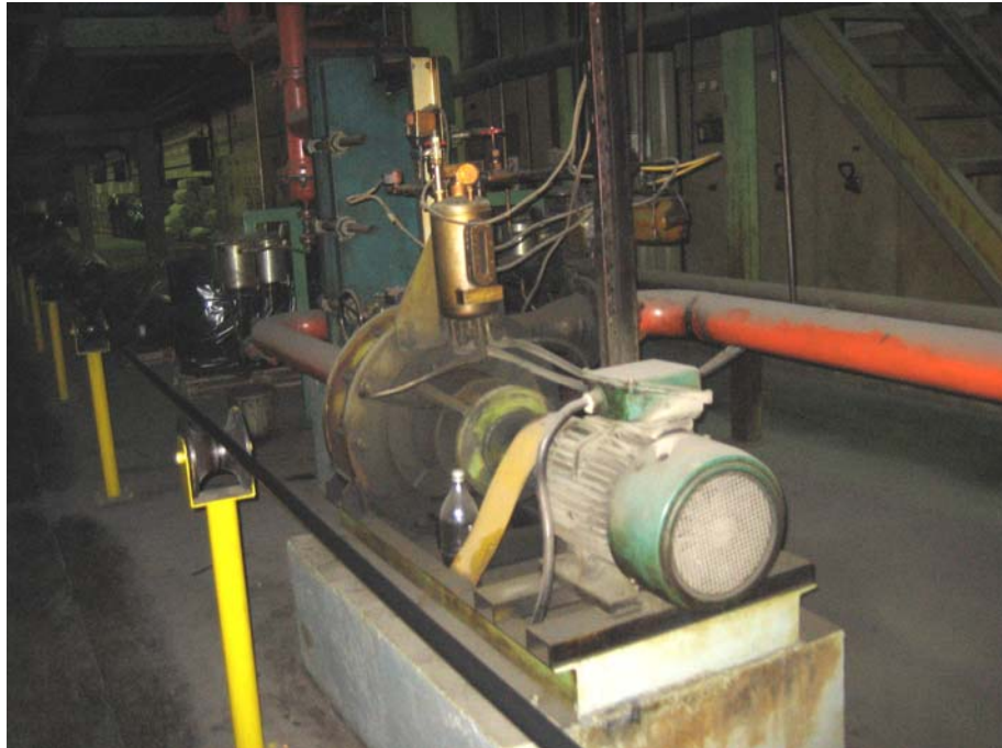
Kuva 8. Typenkiertopuhallinyksikkö
