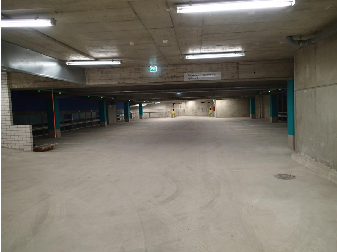
Kuva 7. Vantaalla sijaitsevan Ratakujan parkkihallin paikallavaletut betonirakenteet.
