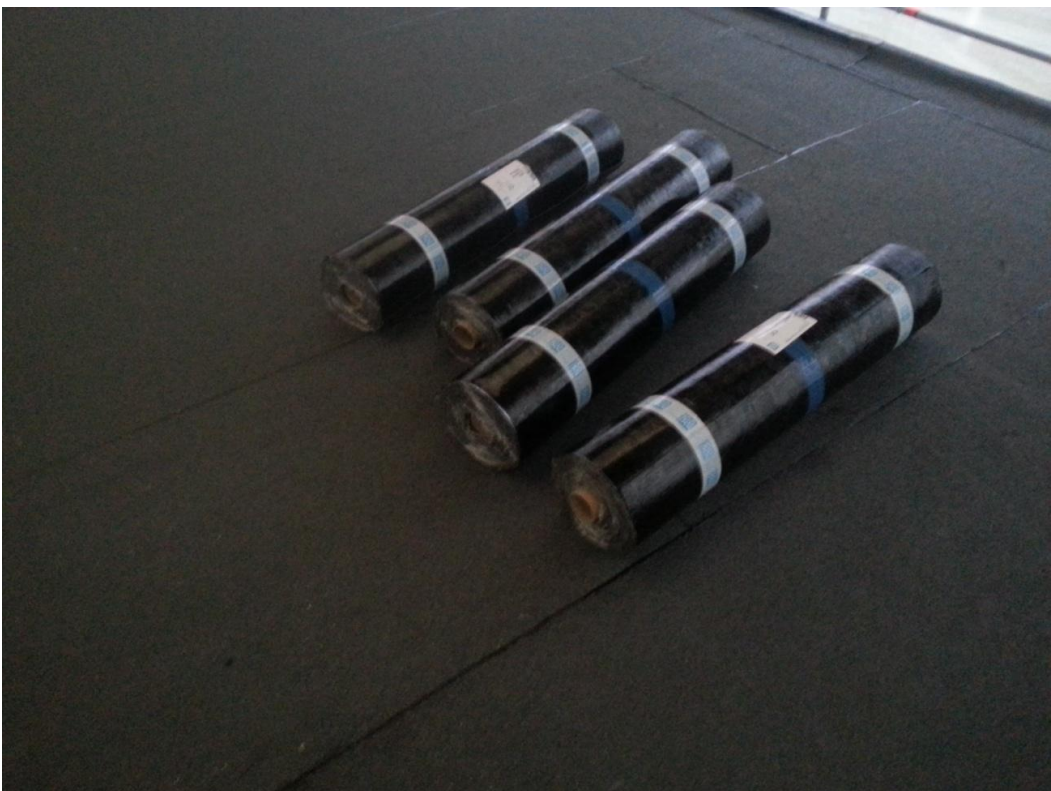
Kuva 9: Pinnalle hitsattavia kumibitumikermejä asennettu (TL2 + TL2)
