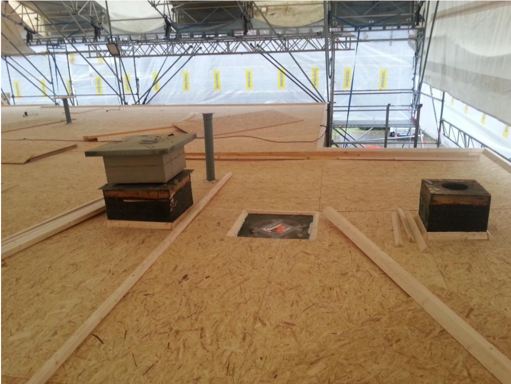
Kuva 8: OSB-levytystyö + hormit ja kattokaivo
