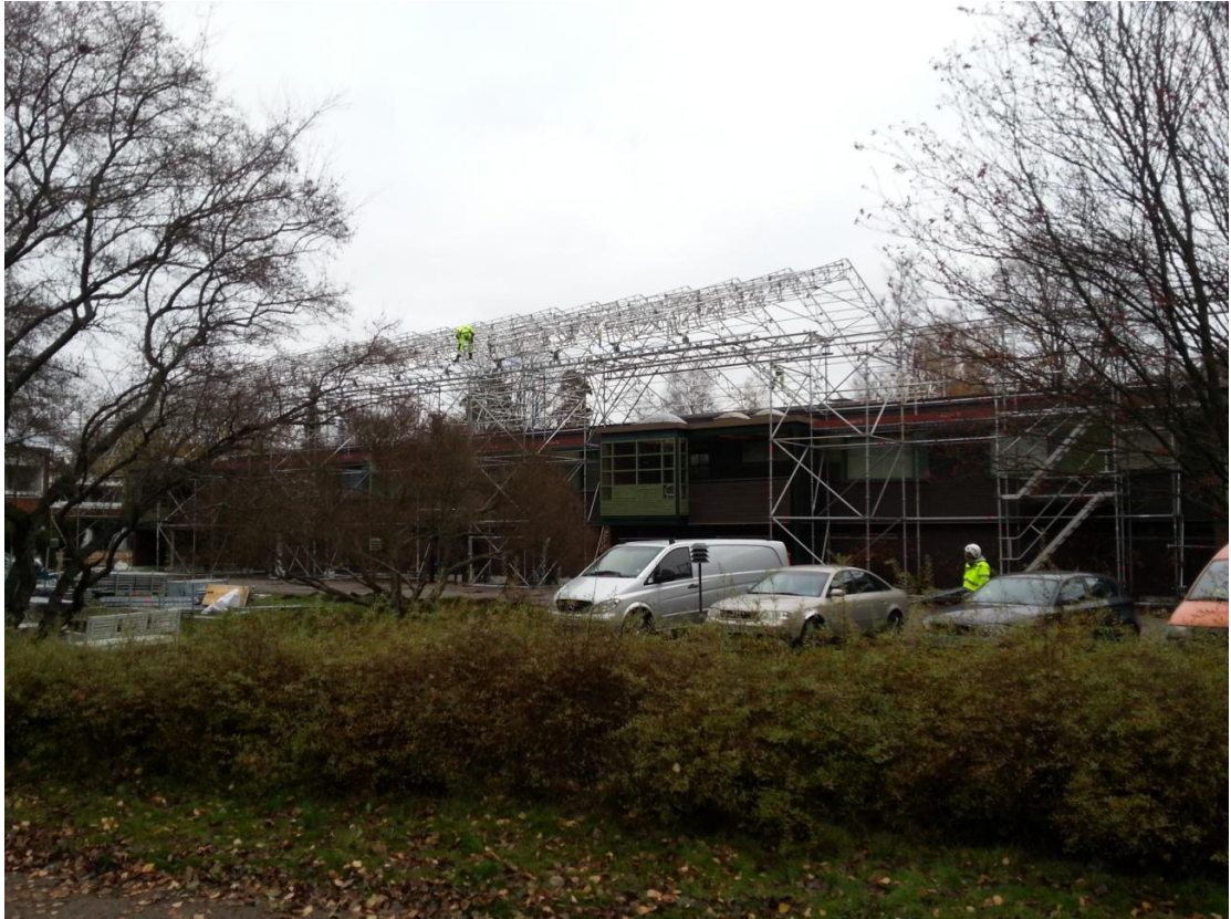
Kuva 3: Sääsuojan kehikon asennusta ja telineet
