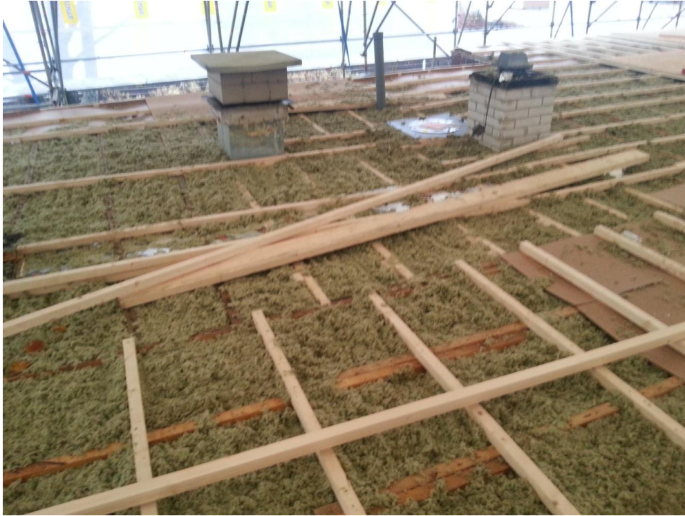
Kuva 7: Tuuletuskoolauksen tekoa kattokannattajien ja puhallusvillan päälle
