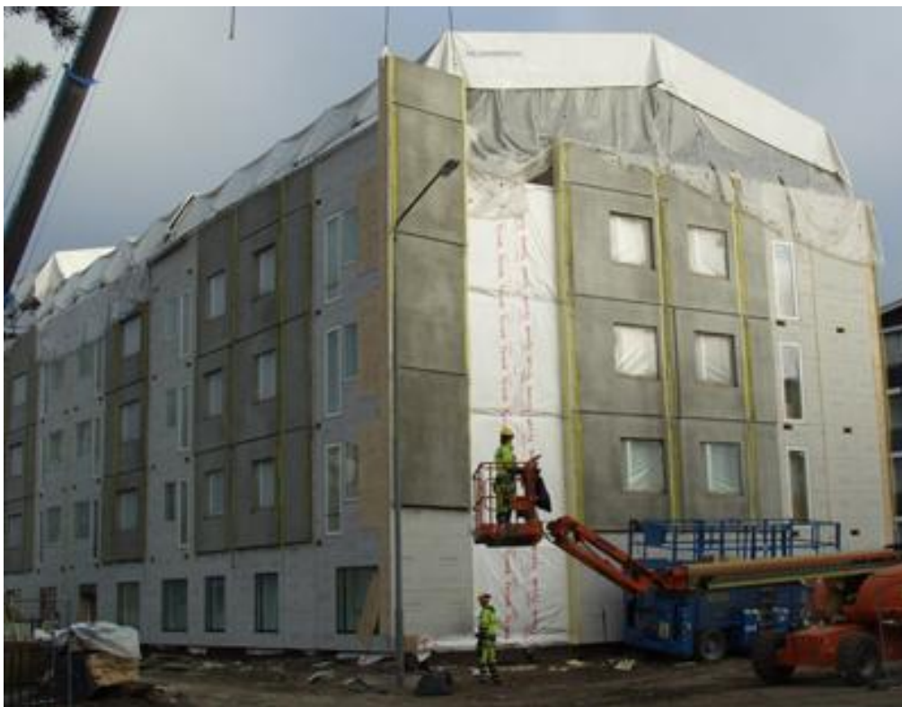
Kuva 3 TES-elementin asennus, Paroc Oy AB
