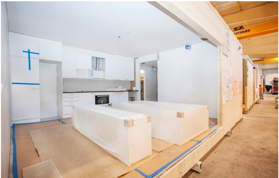
Kuva 9 Tilaelementtien valmistusta tehtaalla, Puuinfo, Storan Enson tilaelementtirakentaminen, 2015c
