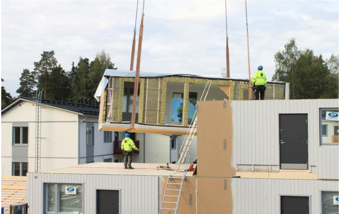
Kuva 10 Tilaelementtien asennusta työmaalla, Puuinfo, Storan Enson tilaelementtirakentaminen, 2015c
