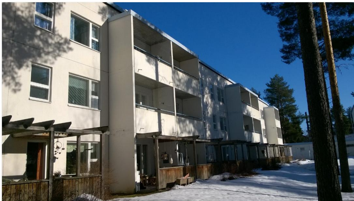
Kuva 12 Kohde Pataluodon haka, julkisivu etelään
