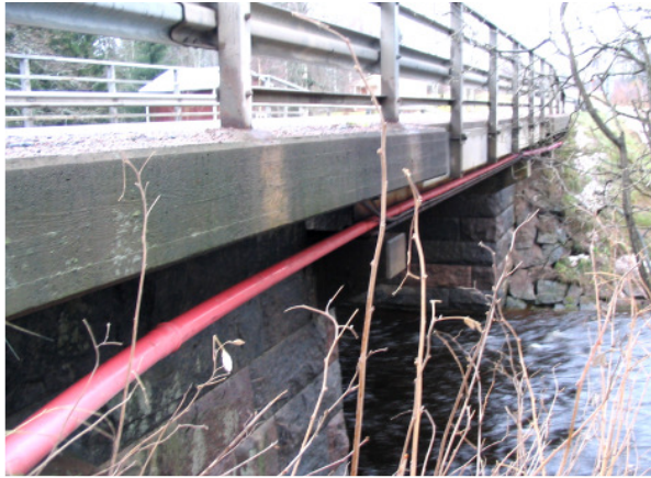
Kuva 6.8 Siikalantien silta Siikalankosken kohdalla.
