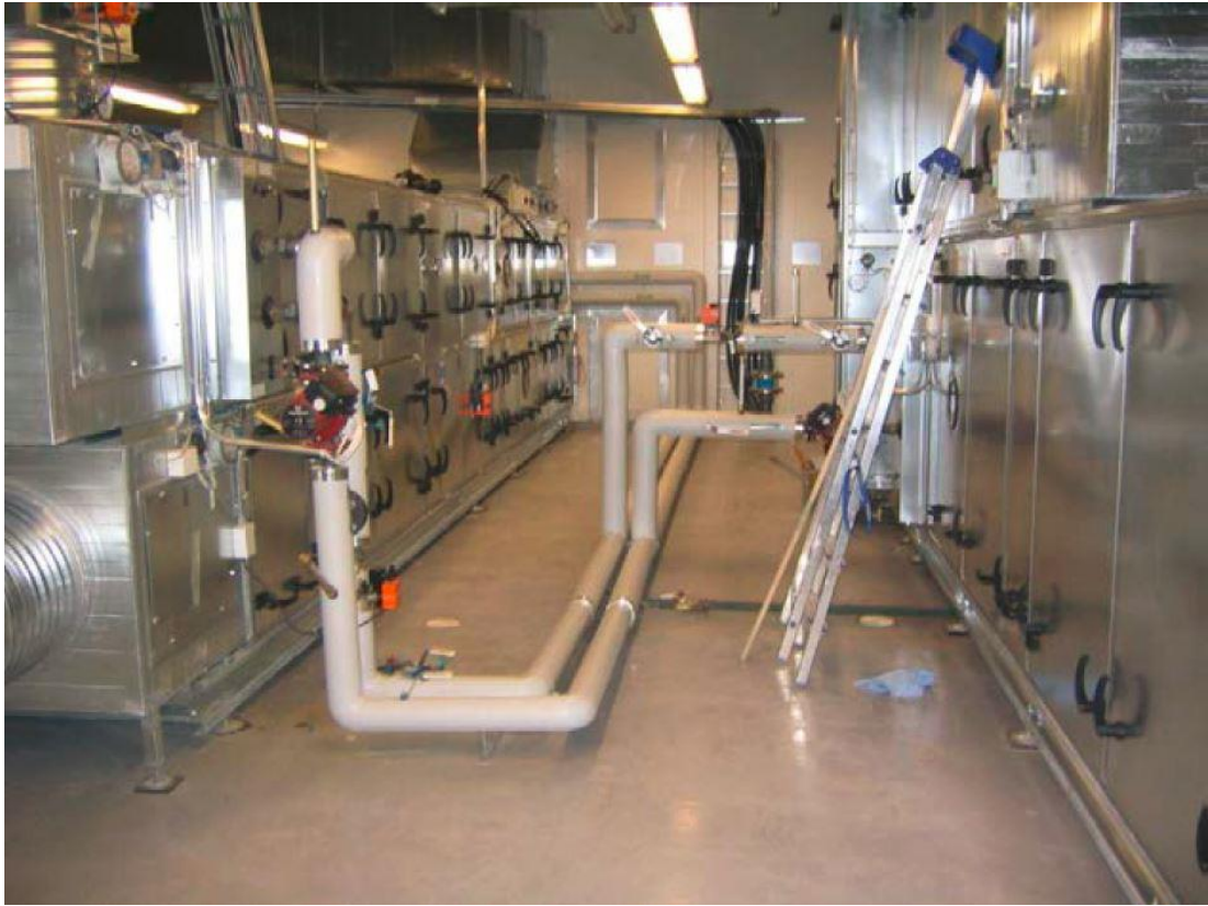
Kuva 3. Ilmanvaihtokoneen nestepiiri (Sulvi www-sivut 2015).
