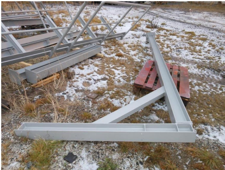
KUVIO 9. Pintakäsitellyt teräsrakenteet ennen asentamista
