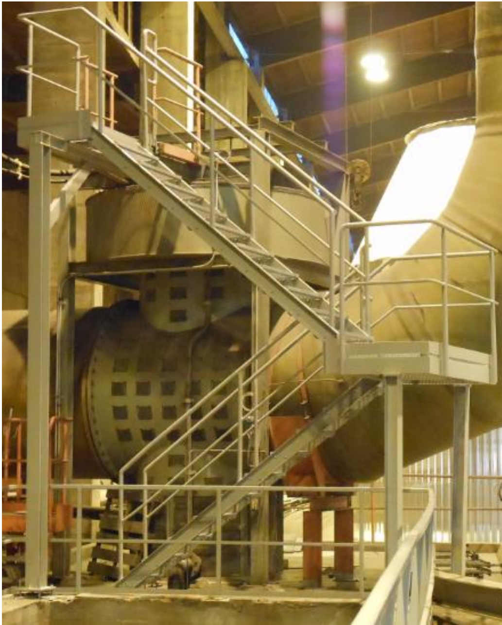
KUVIO 10. Asennettu porraskokonaisuus
